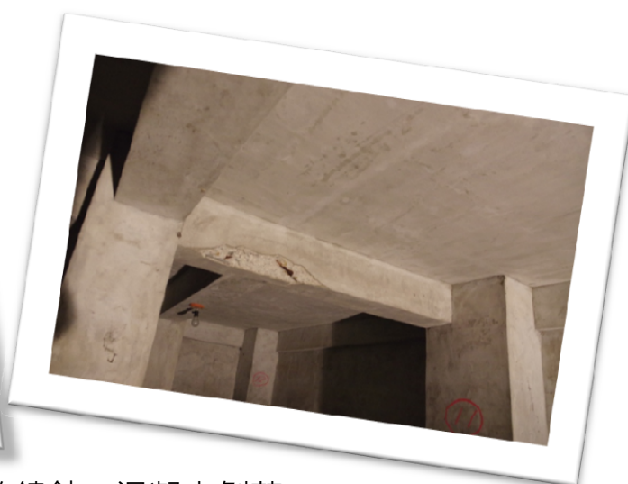
梁柱鋼筋鏽蝕、混凝土剝落
