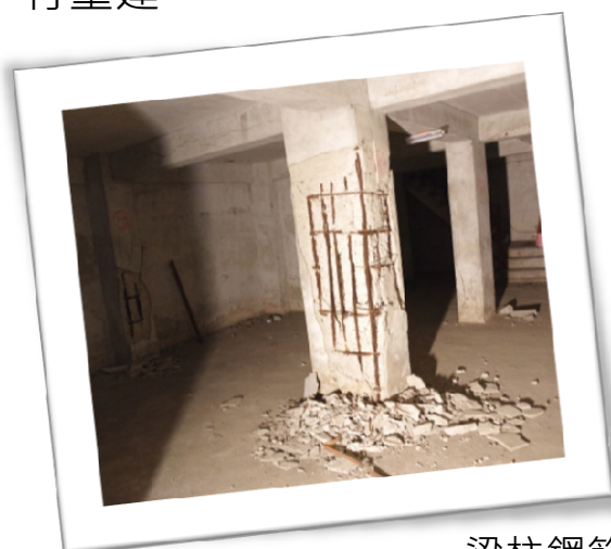
梁柱鋼筋鏽蝕、混凝土剝落
