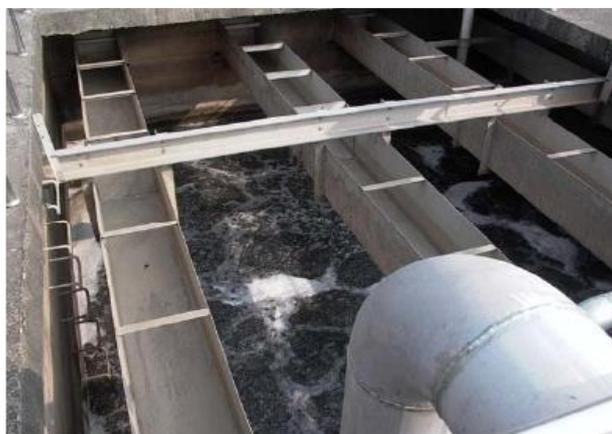
圖 5.44 好氧生物過濾系統(台南市虎尾寮污水處理廠)
