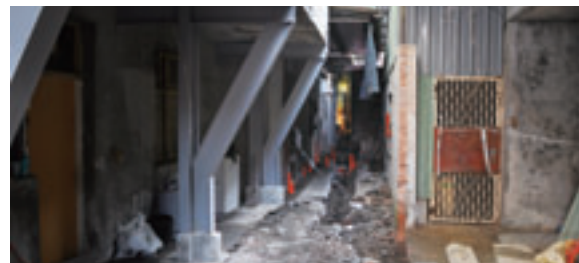
▲五股五標後巷違建拆除支撐
