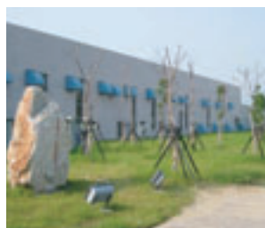
▲內湖污水處理廠廠區
