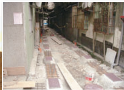
▲汐止污水系統用戶接管施工
