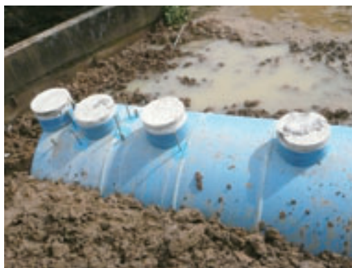
▲合併式淨化槽施工
