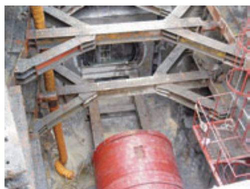
▲龍形繞流管推進工程
