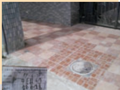
▲復興臺地污水系統用戶接管鋪面復舊
