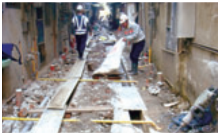
▲吉林路446、461後巷施工
