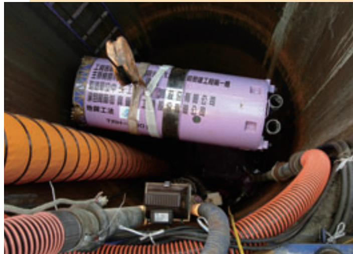
▲新店一標主次幹管施工
