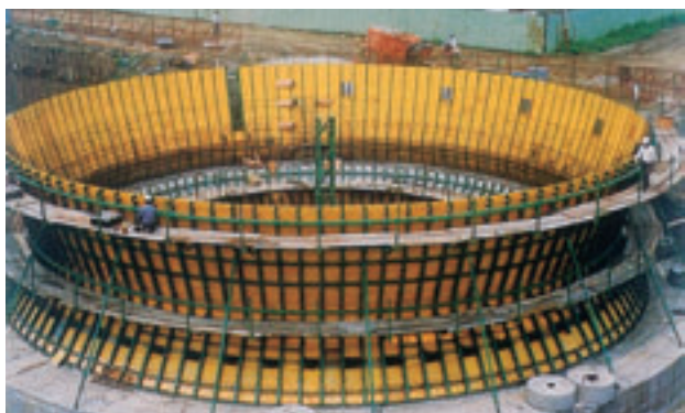
▲八里污水處理廠蛋形消化槽施工情形
