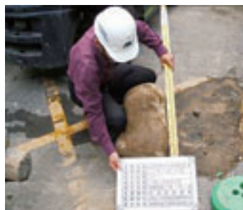
▲新店污水系統管線工程施工遭遇巨石
