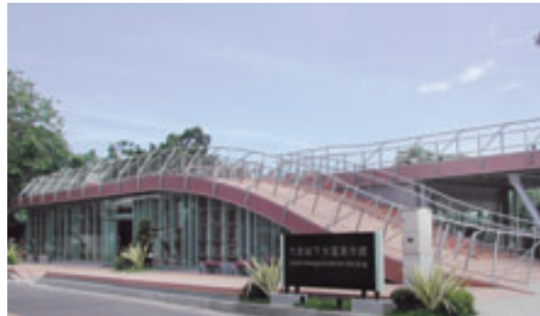
▲六合站下水道展示館
