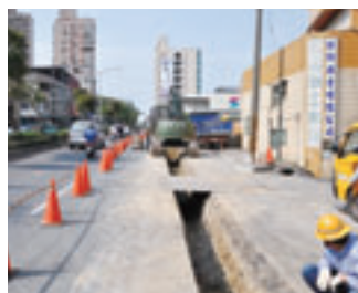
▲ 八里管線七標壓力管線埋設
