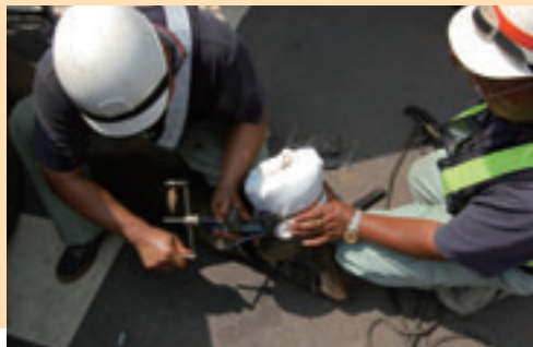
▲林口南區污水系統管線修復工程施工（反轉工法）
