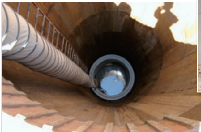
▲汐止一標人孔施築
