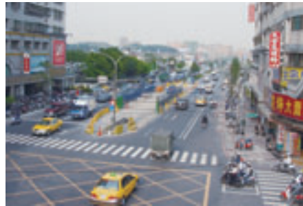
▲ 中和四標施工圍籬佈場作業
