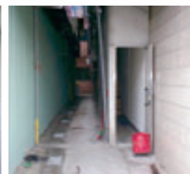
▲三重三標用戶接管施工後
