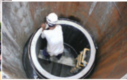
▲新莊二標人孔短管安裝
