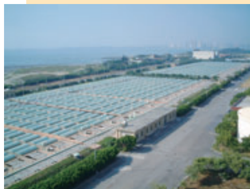
▲八里污水處理廠初級沈澱池
