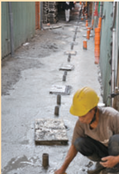
▲五股五標用戶接管施工
