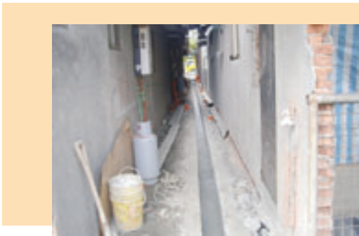
▲ 中和污水系統用戶接管施工
