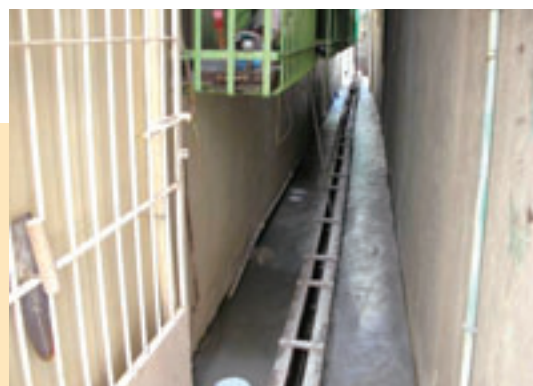
▲鼎山街B區用戶接管施工
