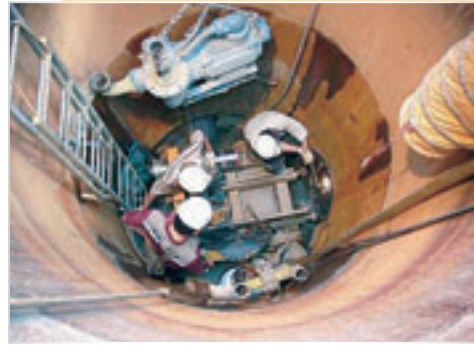
▲五股污水系統管線工程鏡面工施作
