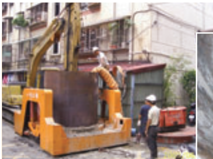
▲新莊二標工作井沉設
