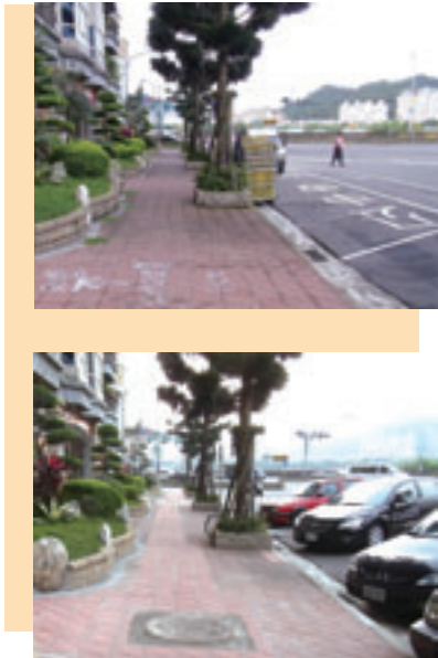
▲新店溪園路湯泉社區前用戶 接管工程施工前後
