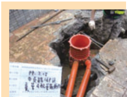
▲復興臺地污水系統用戶接管糞管及配管箱施作
