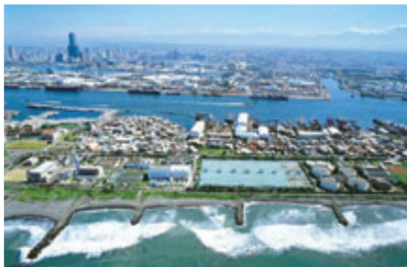
▲中區污水處理廠全景
