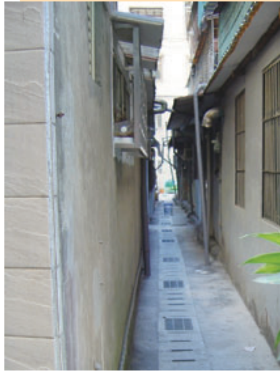
▲永和一標用戶接管完工
