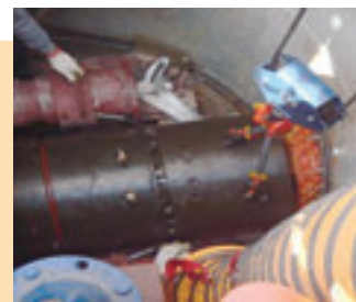
▲石門一標管線推進工程
