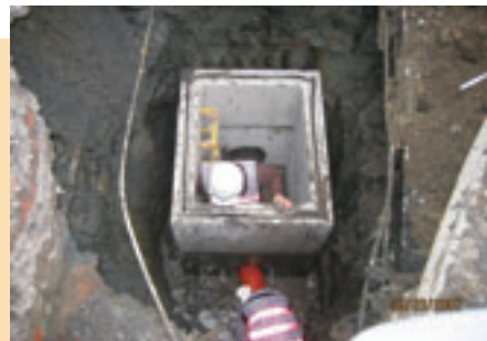
▲ 中和污水系統用戶接管道路段陰井埋設
