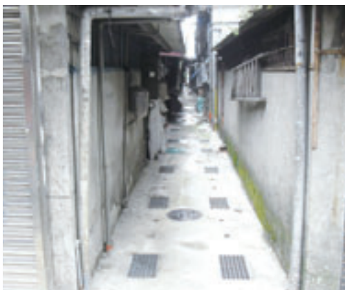
▲板橋九標後巷用戶接管完工
