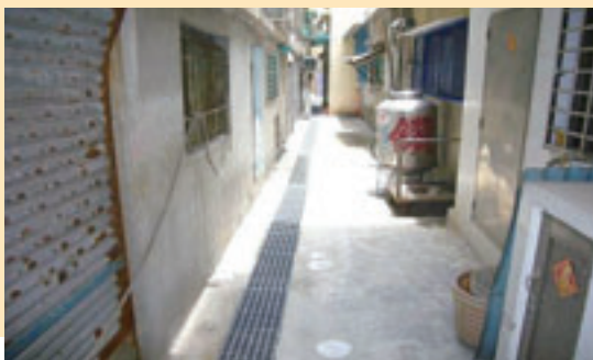
▲華榮路1標B區用戶接管完工
