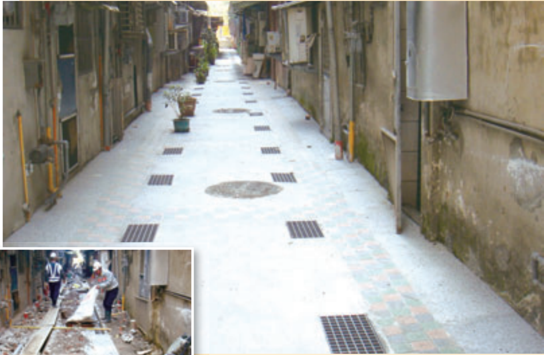
▲吉林路446、461後巷完工
