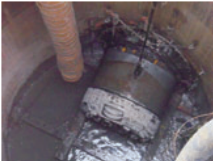
▲永和二標推進完成
