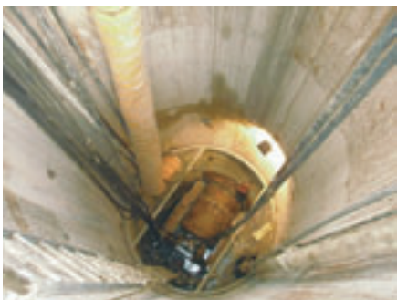
▲永和二標推進施工
