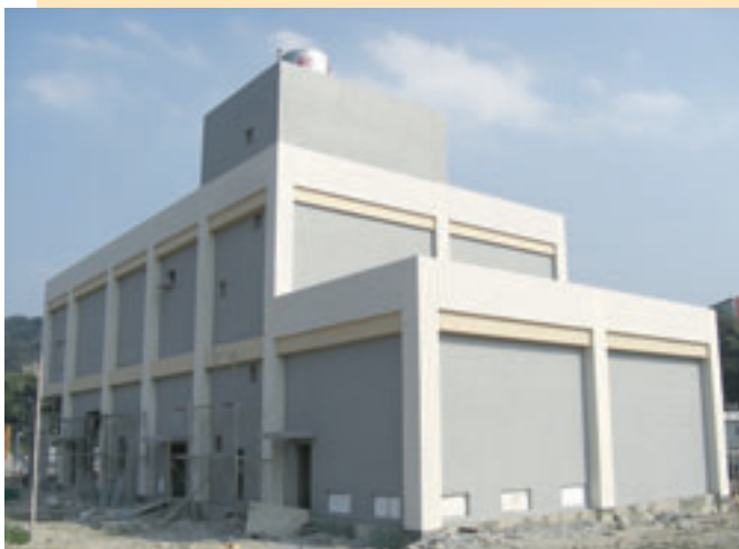
▲大溪水資源回收中心污泥處理機房施工
