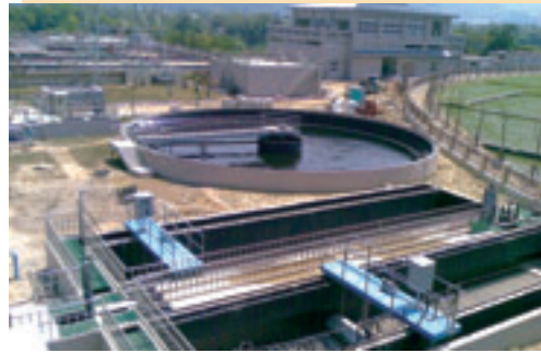
▲石門水資源回收中心施工
