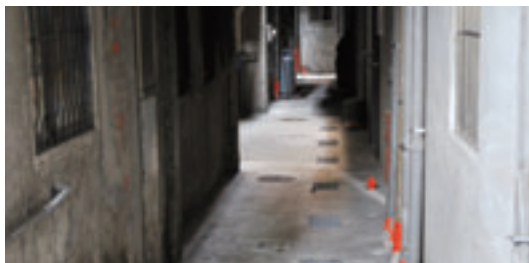
▲五股五標用戶接管完工
