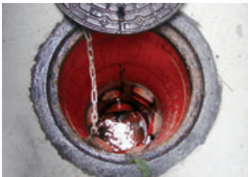
▲板橋九標後巷用戶接管塑膠陰井
