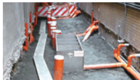
▲新莊四標用戶接管施工
