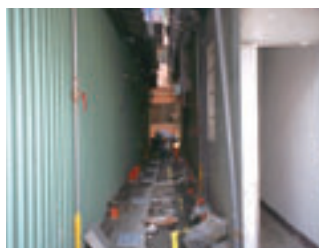
▲三重三標用戶接管施工前
