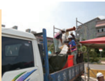
▲林口南區污水系統管線修復工程施工（反轉工法）
