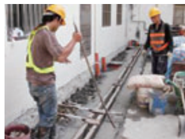
▲蘆洲分管及用戶接管工程第七標施作
