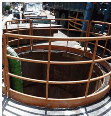
圖 5.1-2 工作井坑周欄杆及腳趾板示意圖
