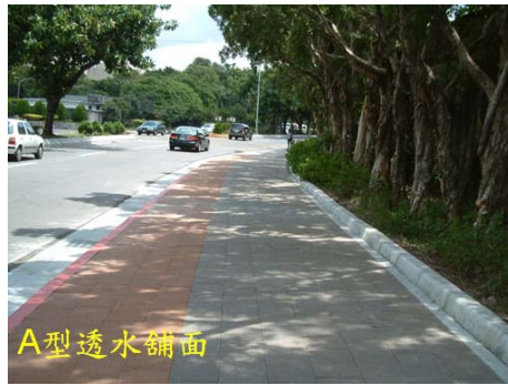
A 型：透水高壓磚擺設完成
