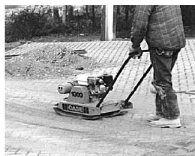
透水磚鋪面層夯實
