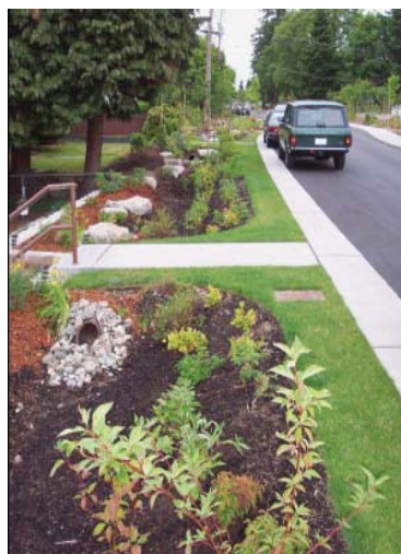
圖 2.14 西雅圖郊區旁草溝排水系統
