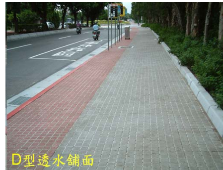
D 型：JW 工法擺設完成
