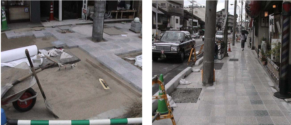
圖 2.21 日本京都市區透水性人行道施工中與施工完成
