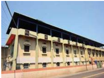
圖 4.12 鴨母港抽水站
