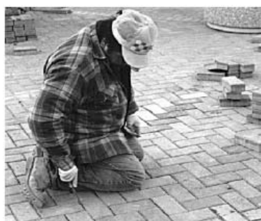
透水磚鋪面接縫調整
