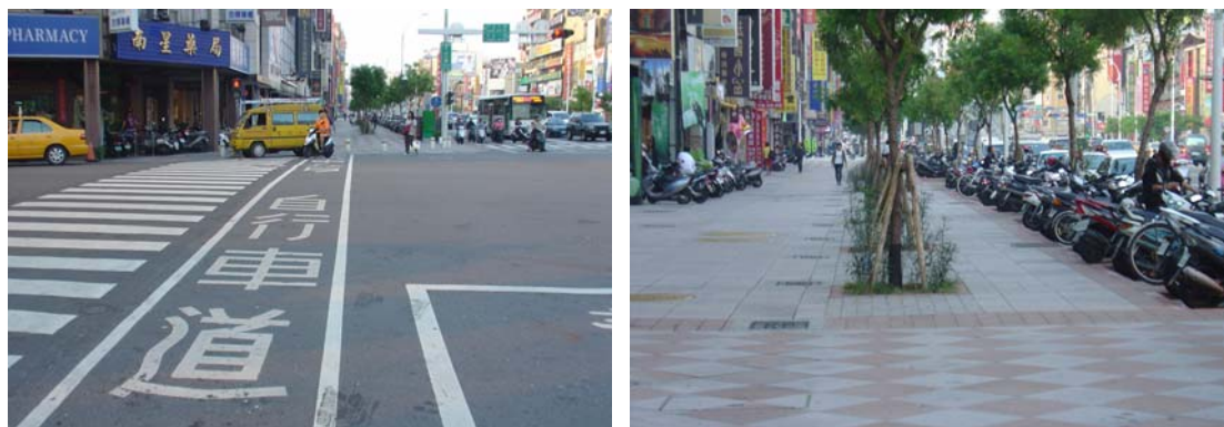
圖 2.102 自行車道之地上標誌及車道劃分不明確
