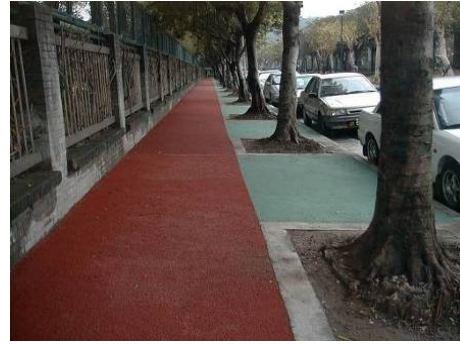
(b) 透水性混凝土
