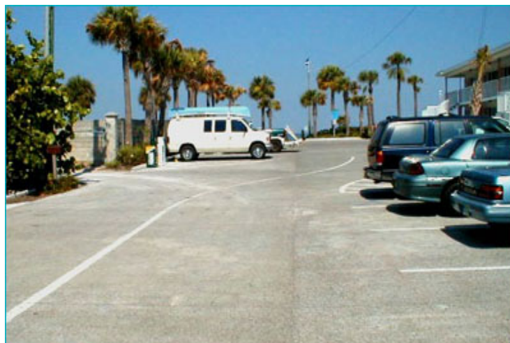
圖 2.25 無細骨材混凝土鋪面停車場
