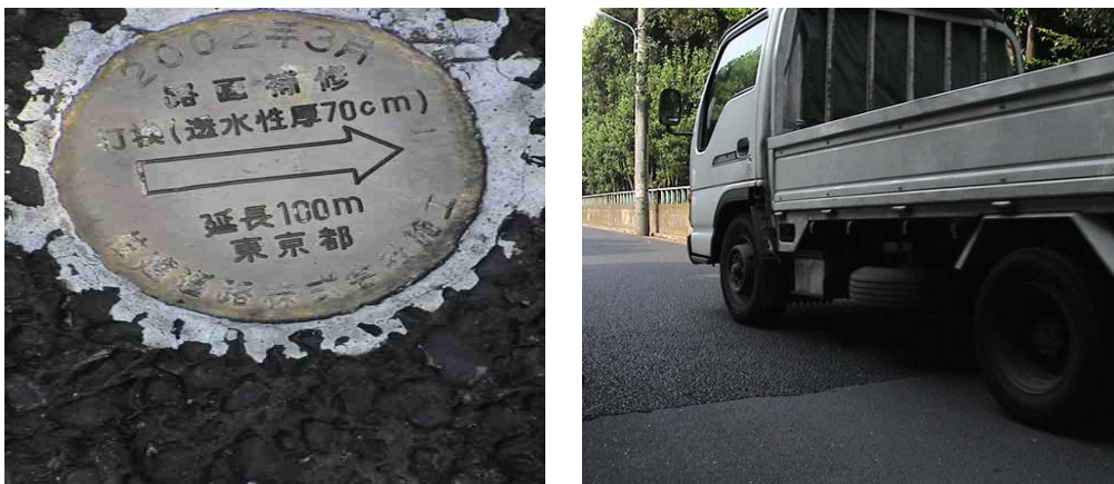
圖 2.22 日本東京都(杉並區)透水性鋪面試驗車道
