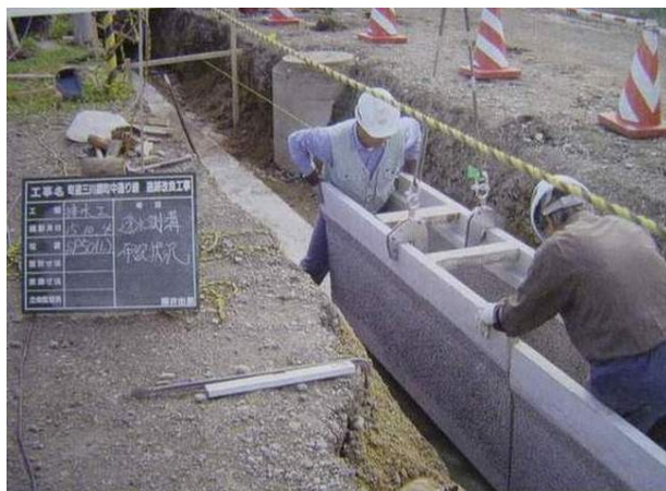
圖 2.35 道路旁施作滲透側溝
