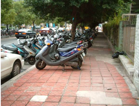
(a) 人行道鋪面未改善前
