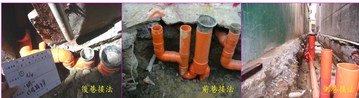
圖 9.1-3 接管方式
