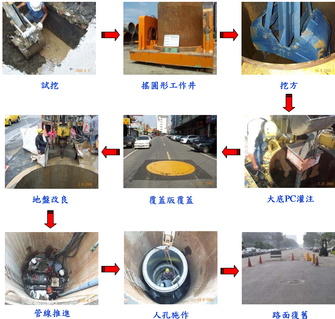
圖 8.1-3 短管推進工法施工流程圖
