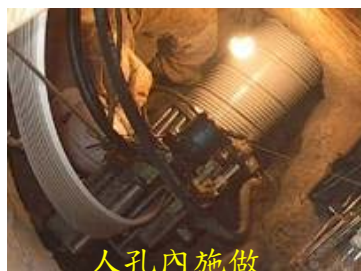
圖 11.3-8 旋轉工法修繕示意圖
