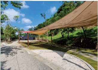
• 動物島(狐狸村)-交營運廠商整備中
