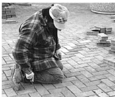
透水磚鋪面接縫調整
