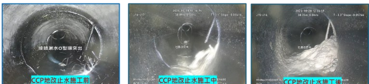
圖 14 管線 CCP 灌漿止水現況成果
