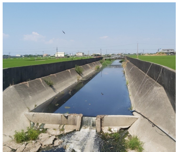
照片 2 區域排水擋水取用現場照片
