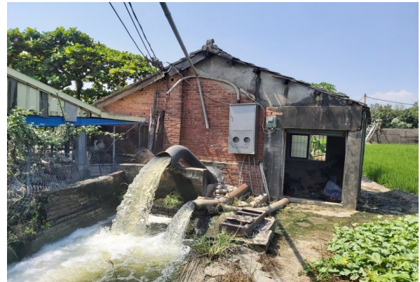
照片 1 早期由部分農民集資設置之引水設施現場照片
