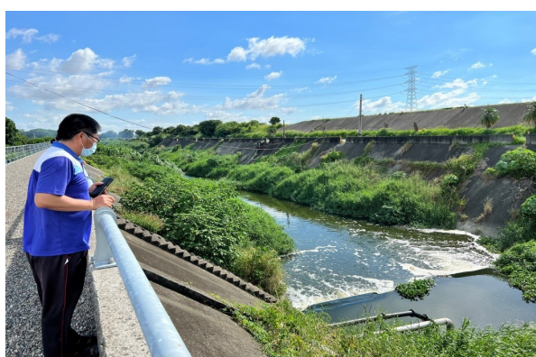
照片 3 河川基流量擋水取用現場照片
