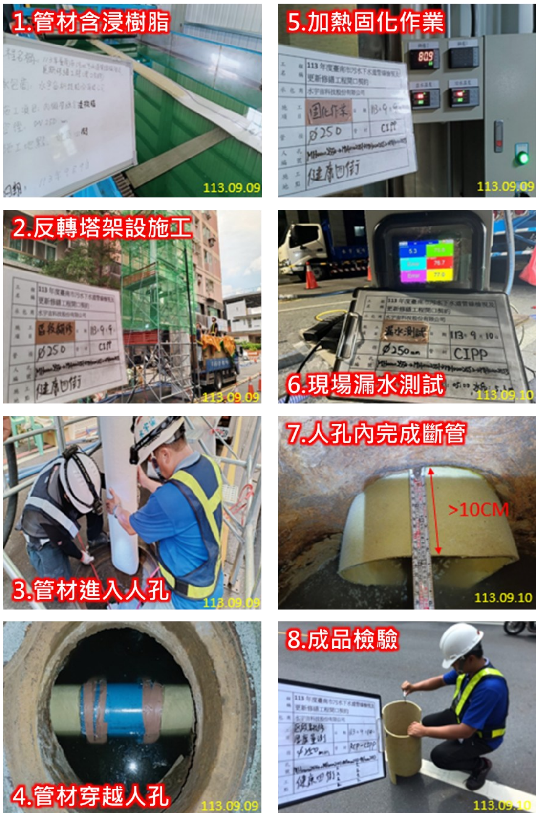
圖 7 CIPP 施工示意圖
