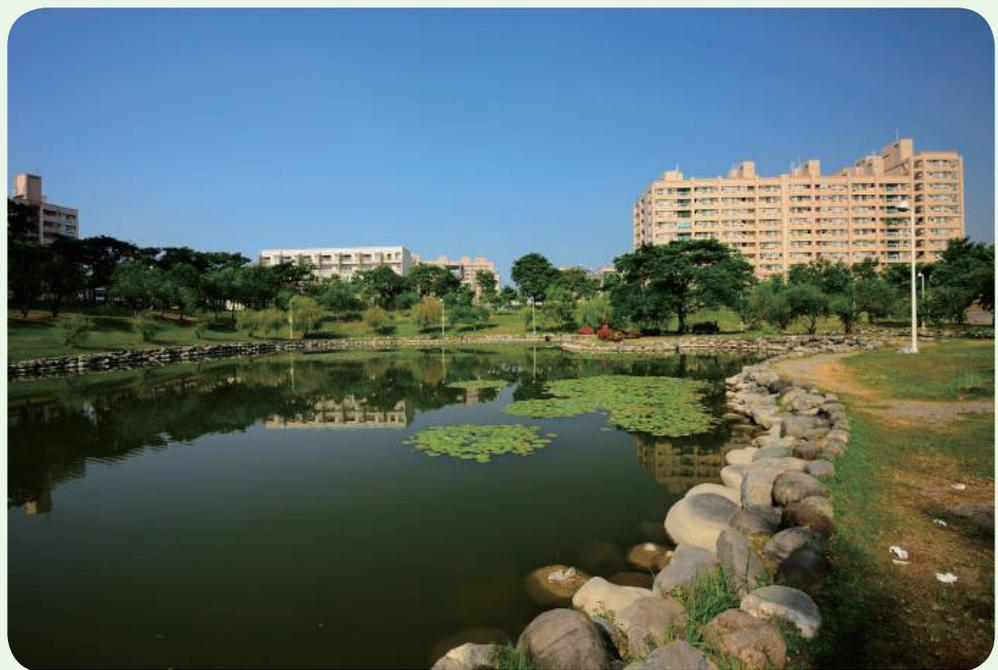
滯洪池降低洪峰流量、延遲水流達到洪峰的時間，使下游地帶免於淹水。在平日，在不影響其滯洪功能的情況下，滯洪池可暫作為庭園景觀、儲水等其他用途，但絕不可隨意移做它用，以免豪雨時無法發揮功能。
