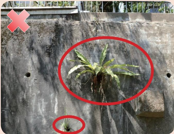
擋土牆建築時，均會設置洩水孔，方便牆後地下水排出，經年累月，孔口泥沙暫留或有植生於孔口生長，造成洩水孔堵塞，需進行清淤以恢復排水功能。
