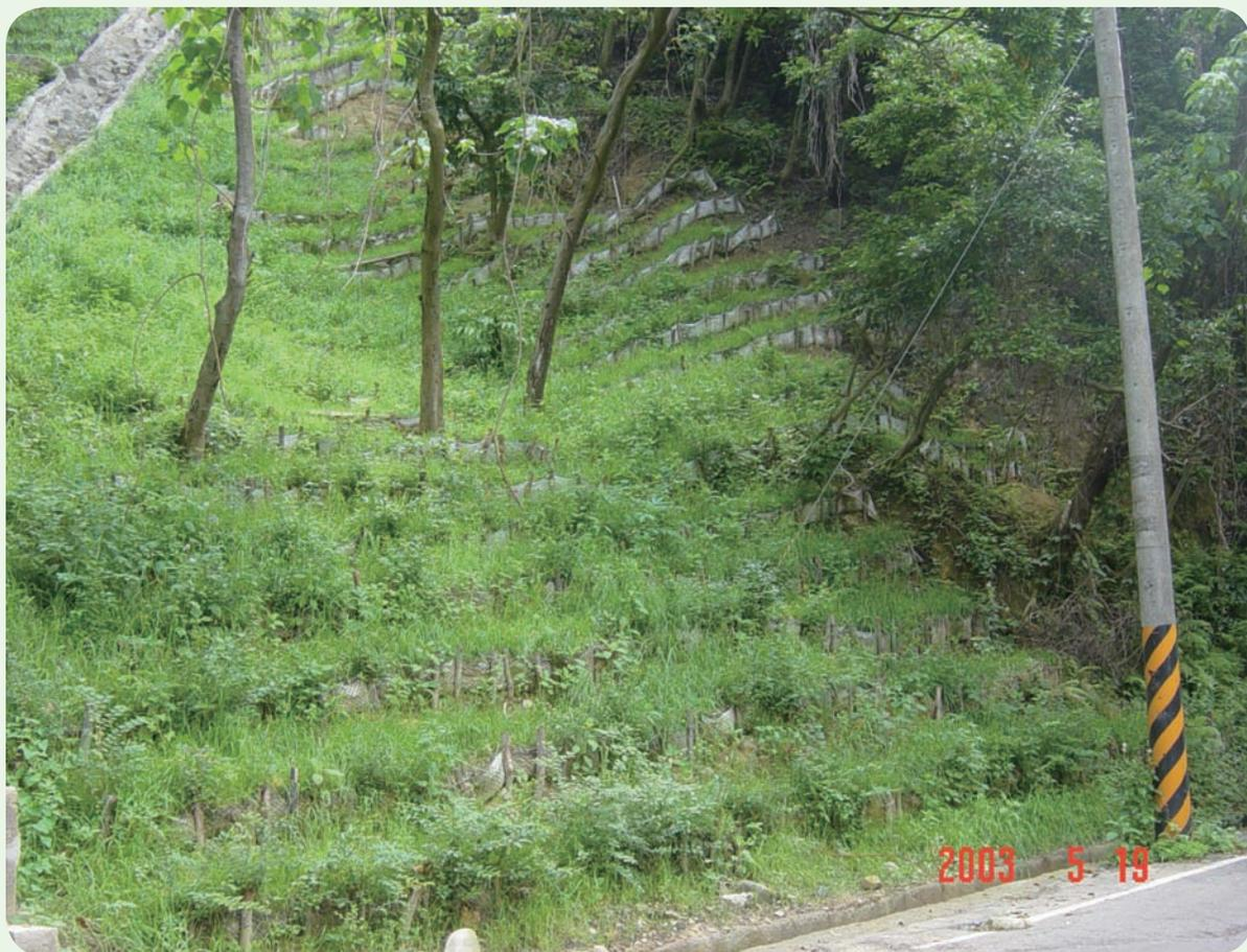
▲照片 2-1-4 打樁編柵植生護坡完工後 (廖瑞堂 攝)
