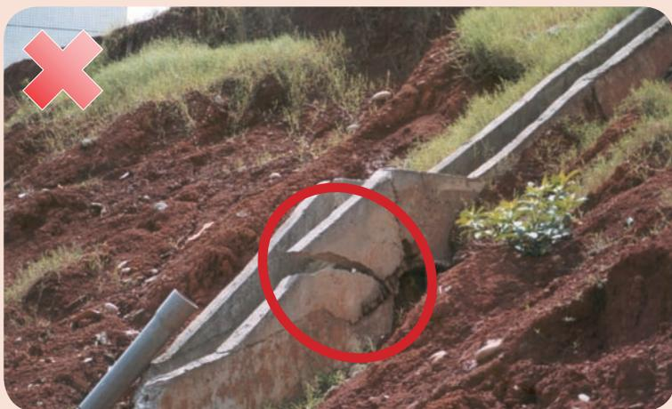
為確保坡地社區之安全，會在道路或邊坡側邊設置排水溝，用以匯集、排放大量地表逕流，導引致安全地點排放，避免坡面或路面因沖刷破壞；排水溝變形常常是坡地災害發生徵兆之一，排水溝強度往往比起建築物設施來的差，如因排水溝裂縫造成長期滲水，可能造成淘空危害。
