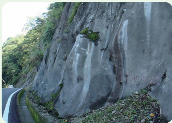
▲照片 2-1-8 噴漿護坡易因老化產生龜裂或滲水現象
