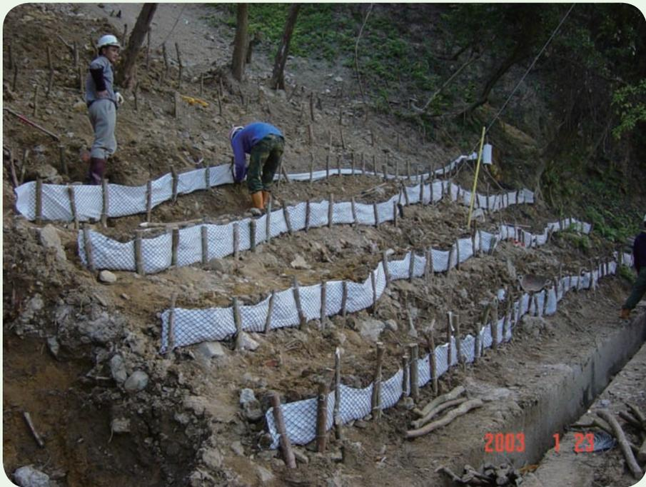
▲照片 2-1-3 打樁編柵植生護坡施工中 (廖瑞堂 攝)
