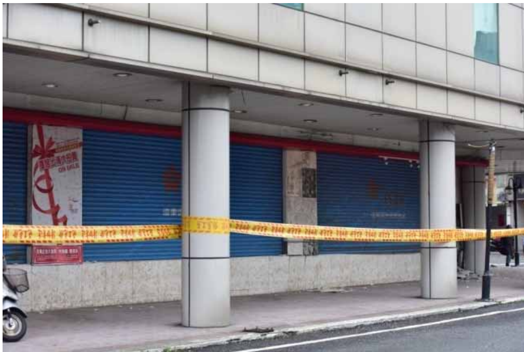
舊遠東百貨大樓 (12層樓) 鋼柱補強
