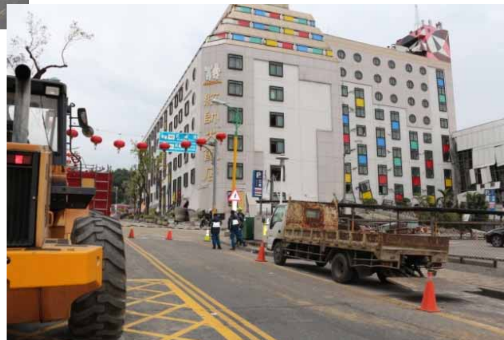
地震後 一、二樓崩塌
