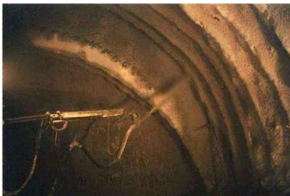
圖 4.1-18 鋼纖維噴凝土施工圖
