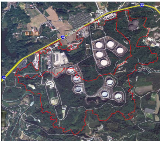
3、台南山上中油豐德供油中心(山保區)(公用設備)
