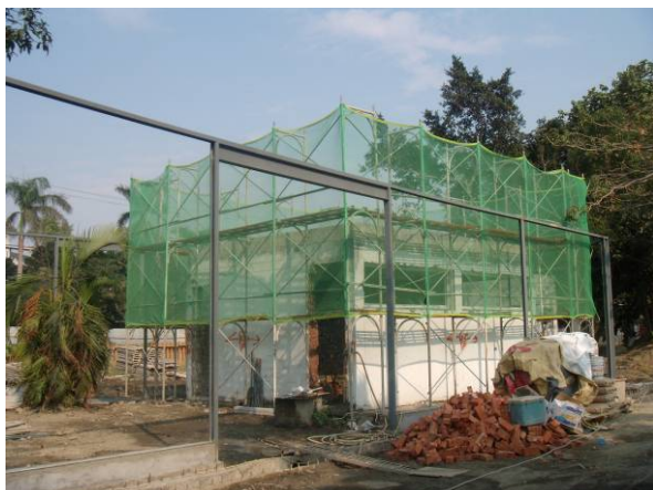
前鎮三角公園暨匯流站改造工程現地
