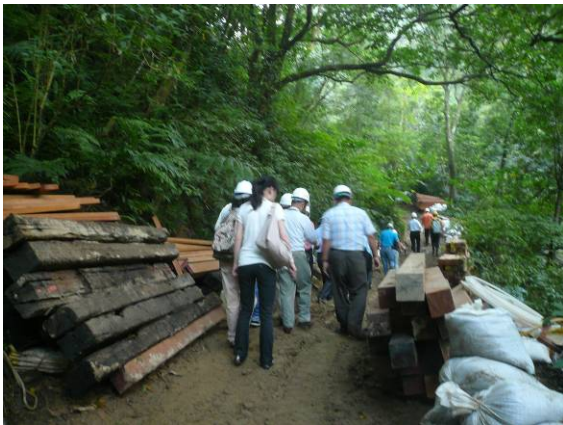
暖暖區老寮坑工程現地
