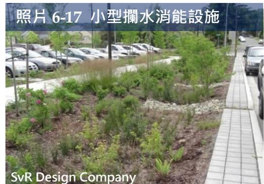
低流速和防止沖蝕。一般可採用石塊堆砌。
