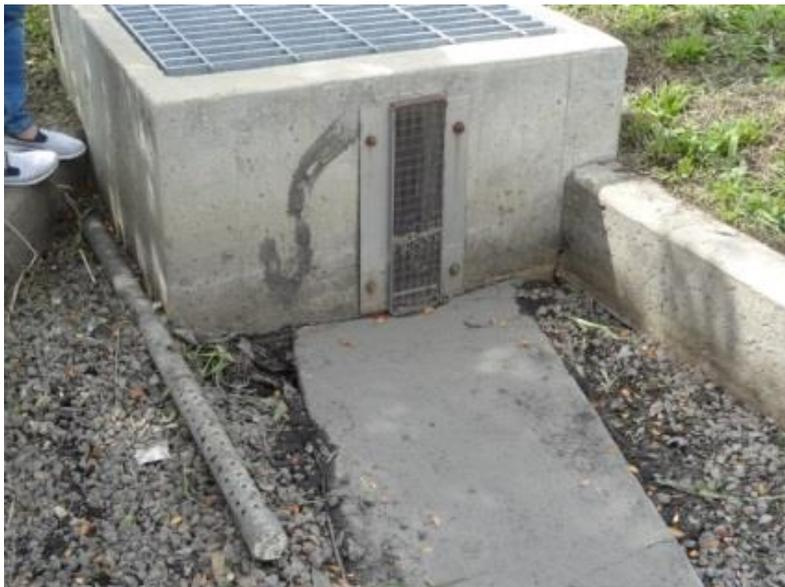
圖6-30 出流口設置之流速儀
