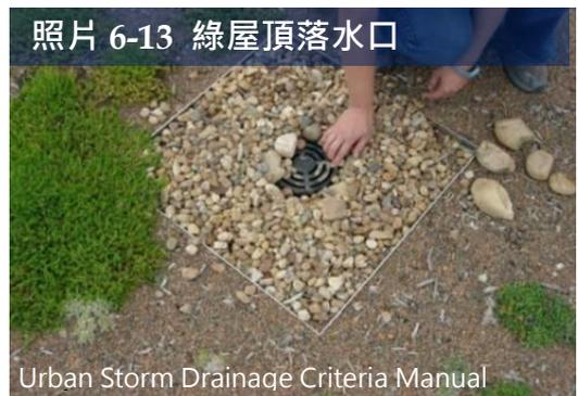
覆蓋屋頂排水孔的礫石（如照片 6-13）。鋼板穿有小孔，提供生長介質排水。其設計示意圖如圖 6-7 所示。
