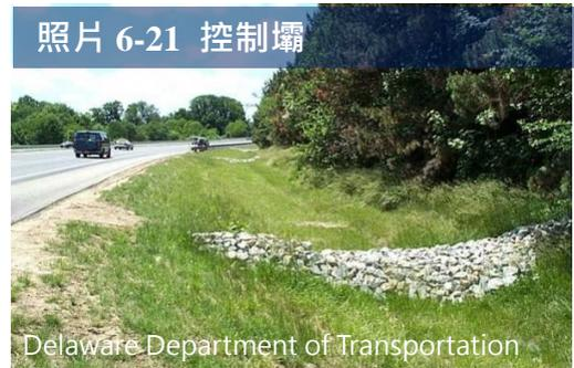
貯水及延長貯流時間，增加水質改善效率，控制壩一般可採用非沖蝕性材料，如：木材 (應含有加壓處理的原木、木材或耐水的樹種)、石籠、拋石或砌石，其下游面宜設置拋石堆消能。
