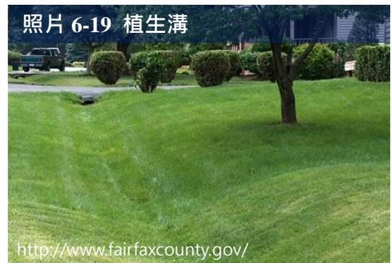
植生溝之種類一般可分為乾式溝 (dry swale) 及草溝渠 (grassed channel) 兩類，其中乾式溝除具有植被之外，另外包含生長介質、過濾貯水層及多孔排水管等結構，因此也可視為滲透溝，設計較複雜之乾式溝有時也被視作線型的生態滯留單元；而草溝渠僅為單純具有植被之植生溝，其與乾式溝有相同的幾何形狀、坡度、控制壩和前處理設施等結構，惟草溝渠主要以水體傳輸為主，較不具入滲功能。本手冊所述之植生溝以乾式溝為主。
