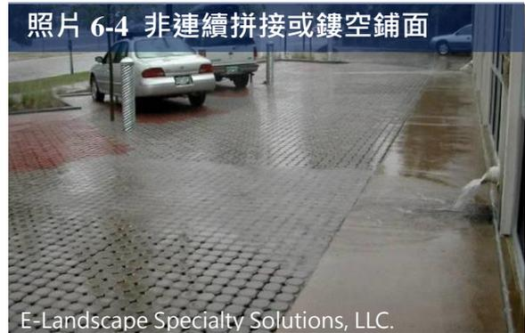
而言，非連續性拼裝塊狀鋪面多為不透水，其鋪面與鋪面間隙填入細砂，鋪面下採用透水性底層如無細骨材混凝土、砂土層，而鏤空的鋪面則直接提供植被生長的環境及水流入滲，使人車行走上面不至造成植物壞死。另外公共工程委員會所列之管式透水鋪面，該工法於不透水表面之間隙中佈設細管，將地表逕流引入下方級配層及保水層貯留，亦為利用間隙入滲貯水，故本計畫亦將此種管式透水鋪面歸類於非連續拼接或鏤空鋪面類型。
