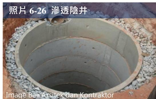
施，與滲透側溝同樣以透水材料製作陰井本體，並以碎石材料填充周圍（照片 6-26）。逕流透過排水系統或地表入口柵欄進入陰井後，可暫時貯留並使部分逕流量滲透至底部與四周的土壤。
