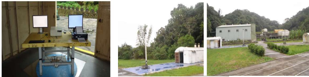
圖 1 戶外型電磁波相容檢測實驗室內外部與周邊情形圖
