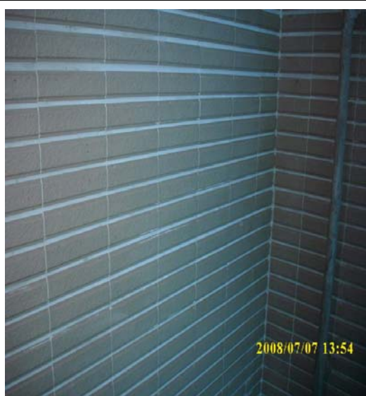
▲整建施工中貼磚完成
