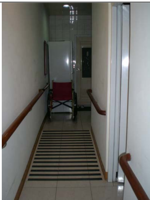
▲室內走廊兩側裝設扶手，且斜坡地面貼止滑材料
