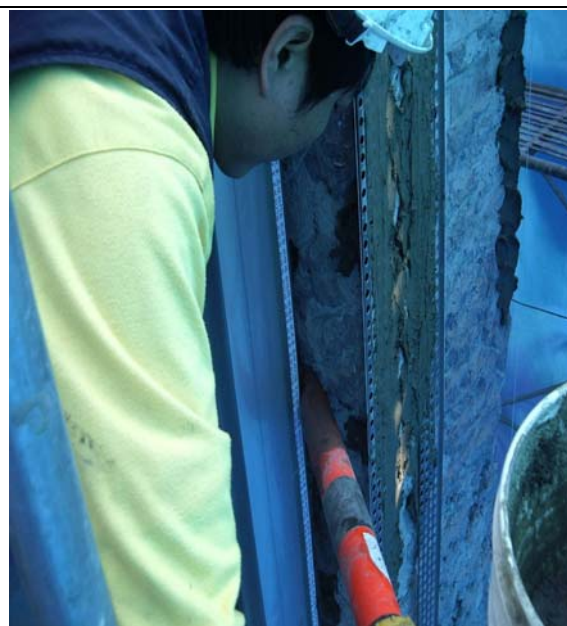
▲整建施工中鋁窗更新後進行窗框嵌縫
