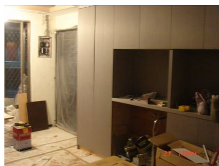
隔間完成實況
