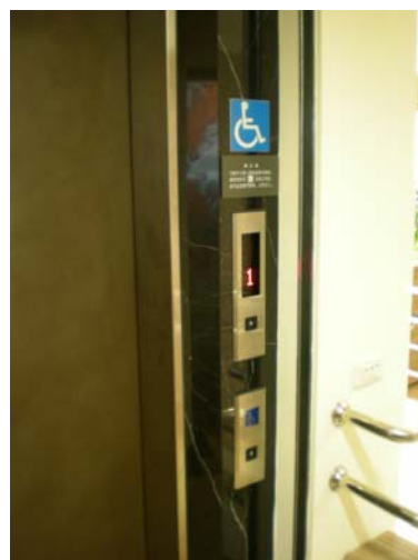
▲電梯入口增設輪椅使用高度之觸摸面板
