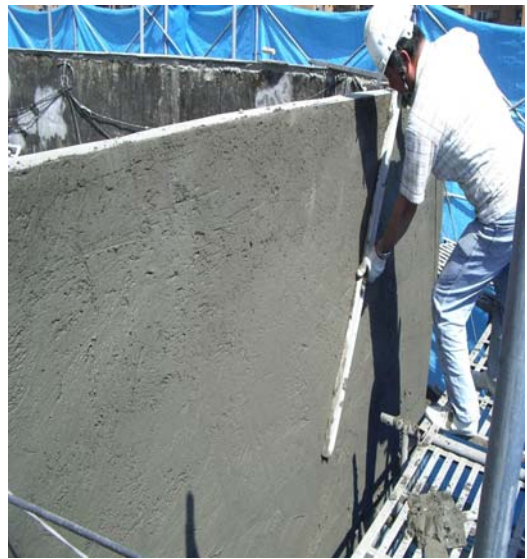
▲整建施工中粉刷工程施作
