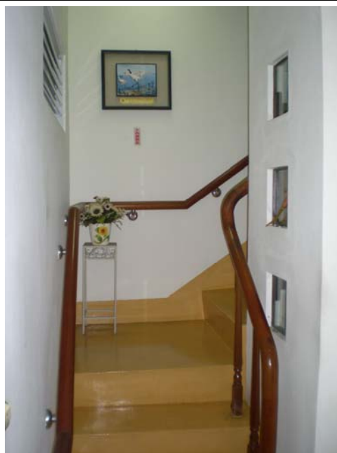
▲樓梯兩側加裝老人使用扶手
