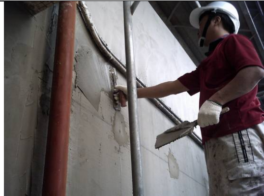
▲整建施工中塗抹第二層高分子樹脂 粉刷材
