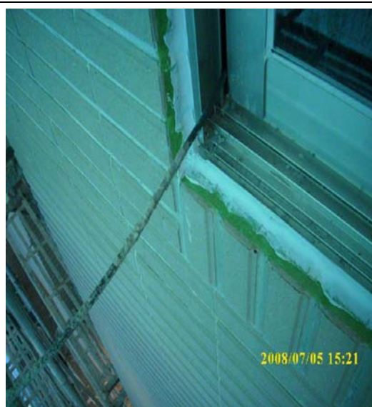
▲整建施工中窗框矽利康
