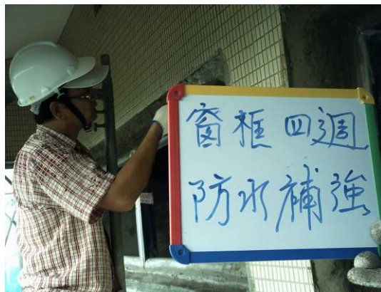
▲整建中窗框周沿塗膜水和凝固型防 水材補強
