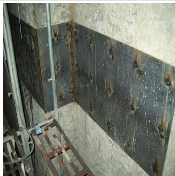
▲整建施工中鋼板補強
