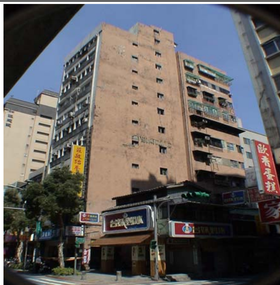
▲整建前建物外牆面情形
