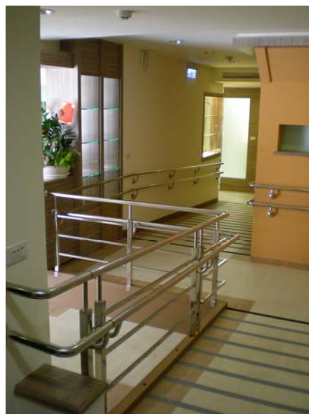
▲室內斜坡道兩側裝設扶手，斜坡地面貼止滑材料
