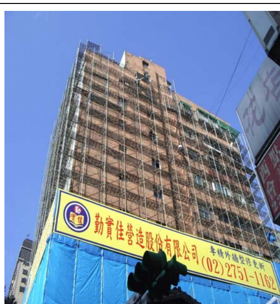
▲整建施工中施工架搭設
