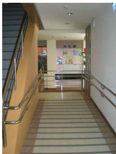
▲於樓梯側面增設老人使用斜坡道
