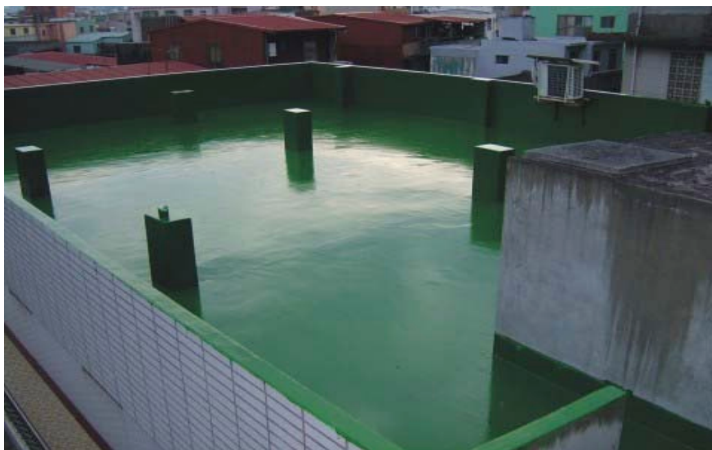
屋頂防漏水整建。
