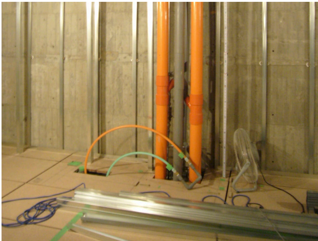
管線的鋪設是整建工程很重要的項目。
