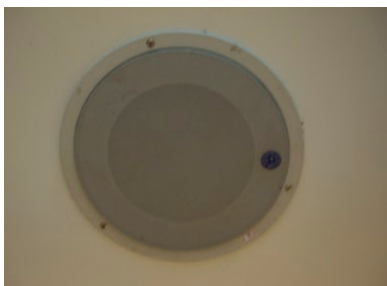
消防栓內水帶與緊急廣播系統
