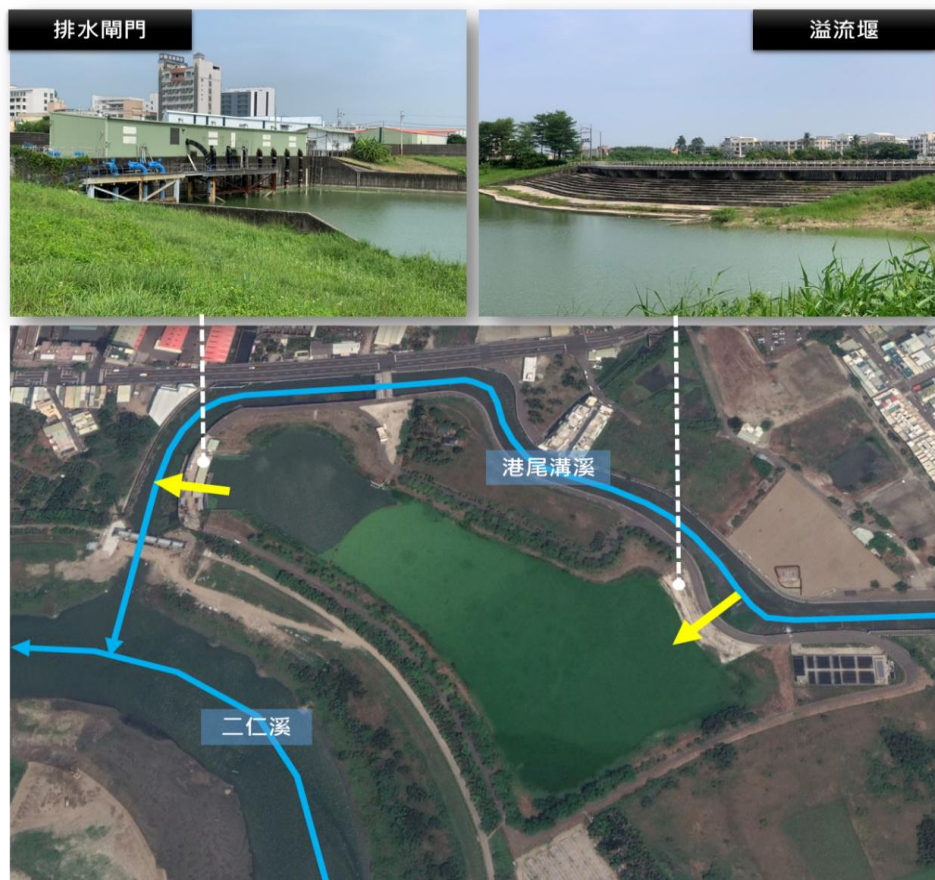
圖 3 港尾溝滯洪池進出口型式流向及現勘照片
