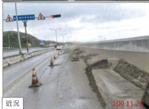
圖 6-8 小南灣段淤積造成沙土入侵道路影響交通狀況
