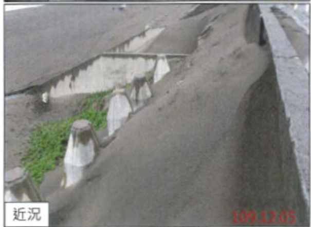
圖 6-8 小南灣段淤積造成沙土入侵道路影響交通狀況
