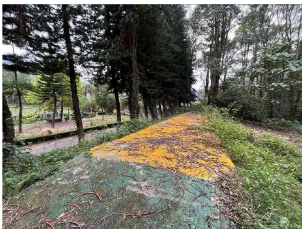
空中單軌(停止使用-現場已全數拆除)
