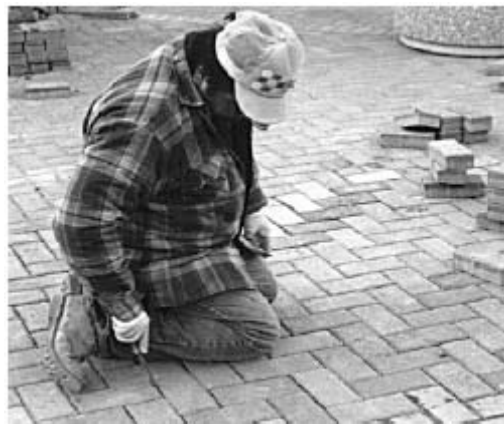
圖 2.7 透水磚鋪面接縫調整
