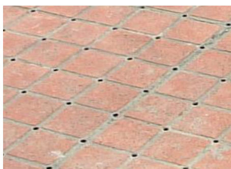
環保透水透氣混凝土鋪面
