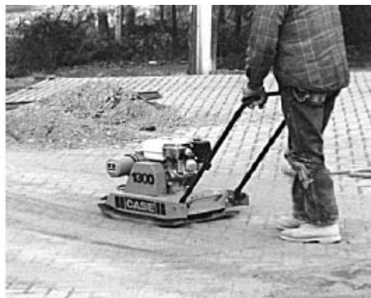
圖 2.8 透水磚鋪面面層夯實
