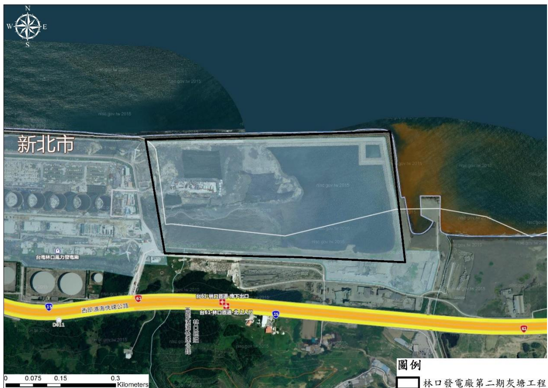
圖 3-2-9 林口發電廠第二期灰塘工程衛星現況圖
