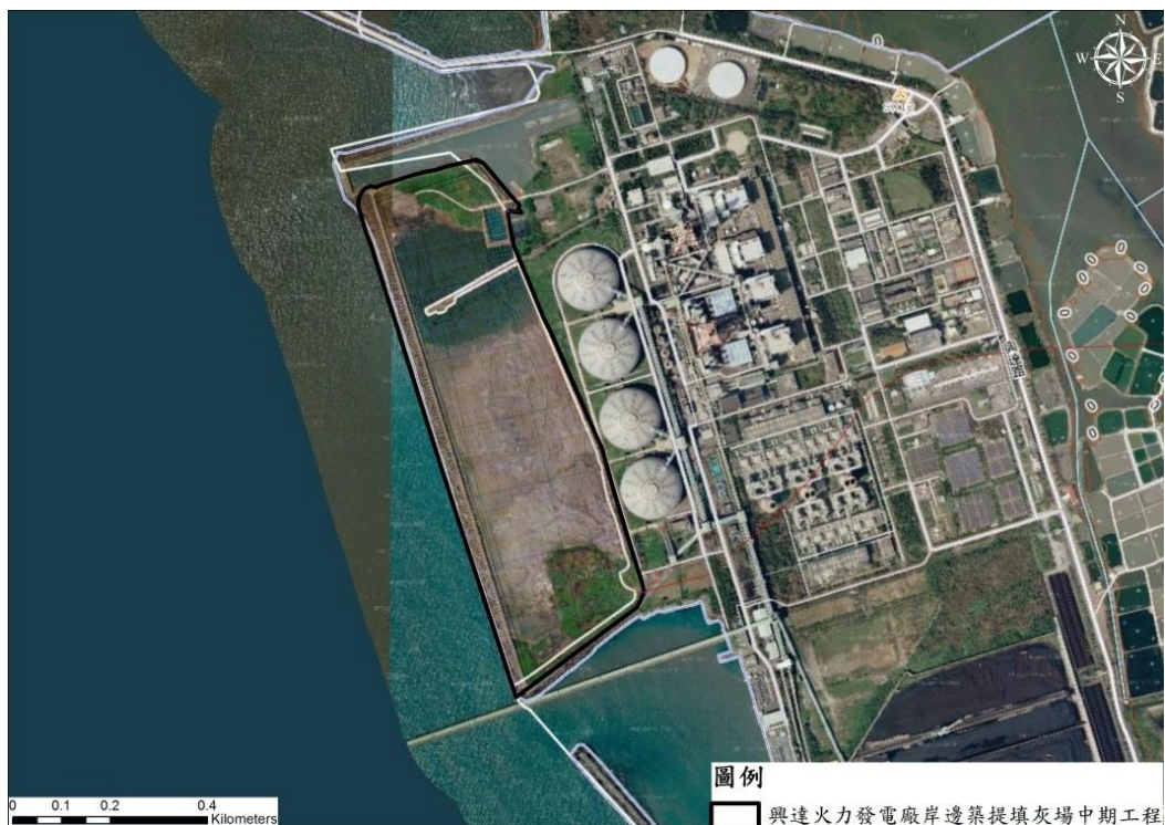
圖 3-2-5 興達火力發電廠岸邊築堤填灰場中期工程衛星現況圖
