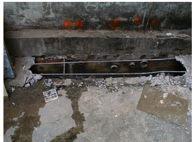
用戶接管施作前
