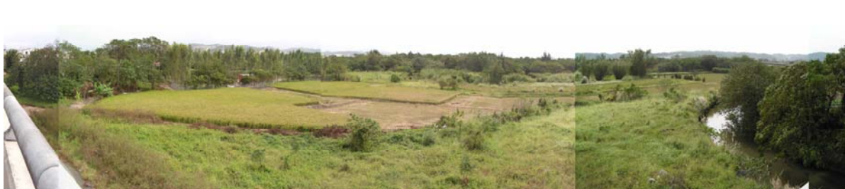
圖 1-38 水資源回收中心現況
