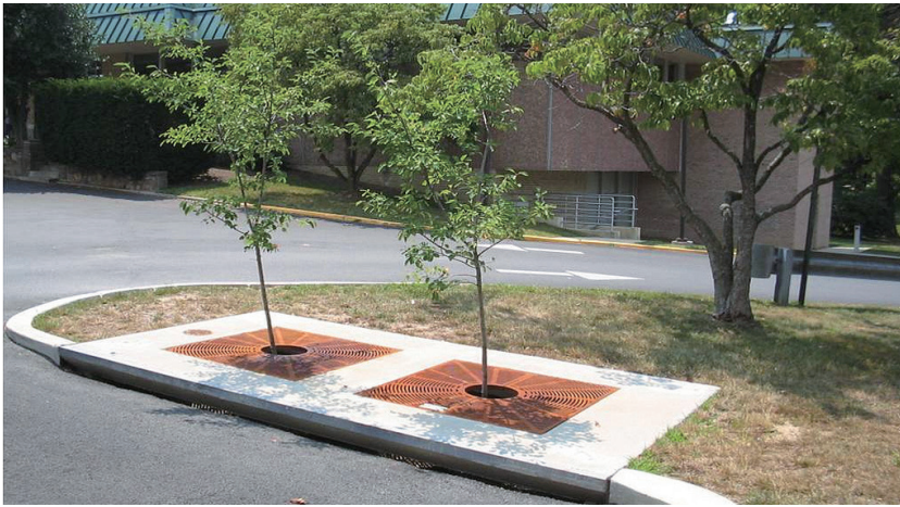
樹箱過濾設施
