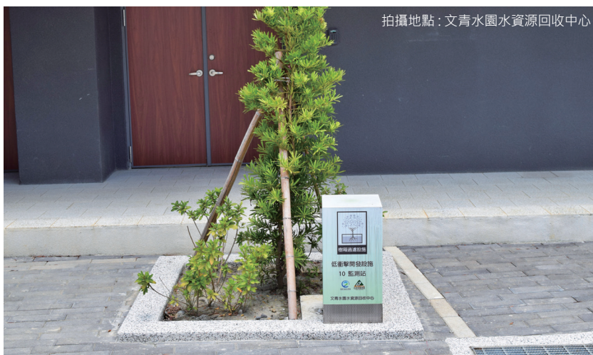
樹箱過濾設施
