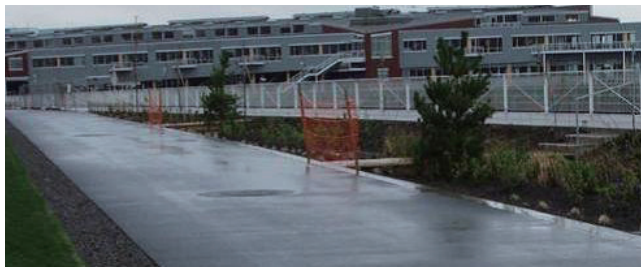
側向前處理設施
