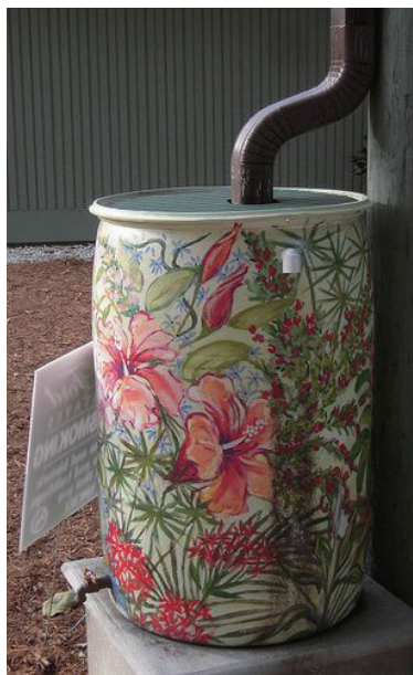
落水管出口直接連結雨水桶
