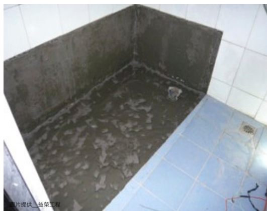
水泥砂漿防水工法
