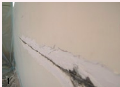
灌漿注射法施工過程
