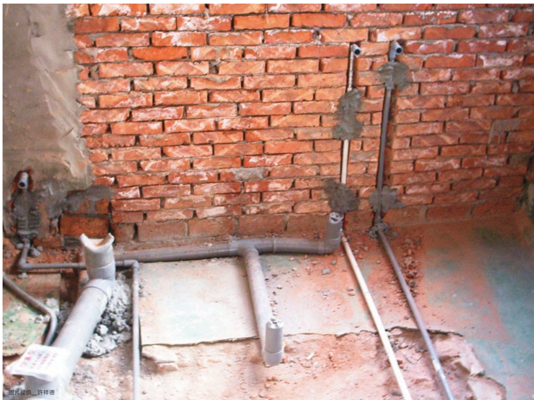
排水管線，配置不可影響建築物安全。
