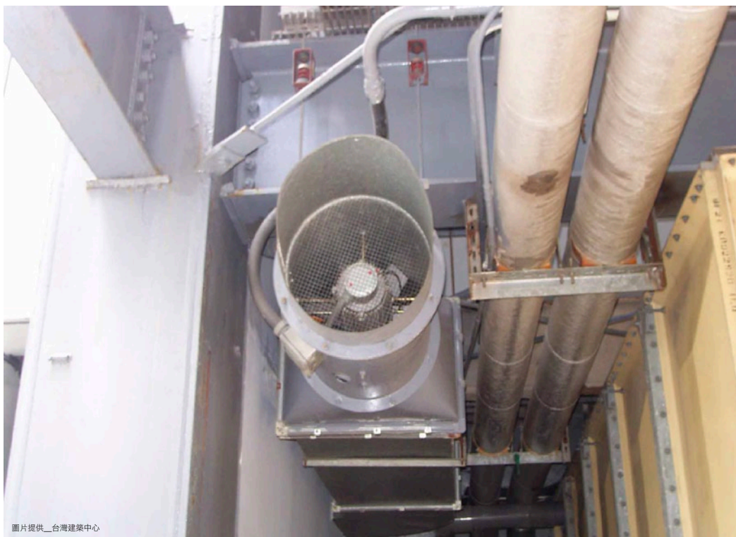
集合住宅大樓頂樓緊急排煙設備
