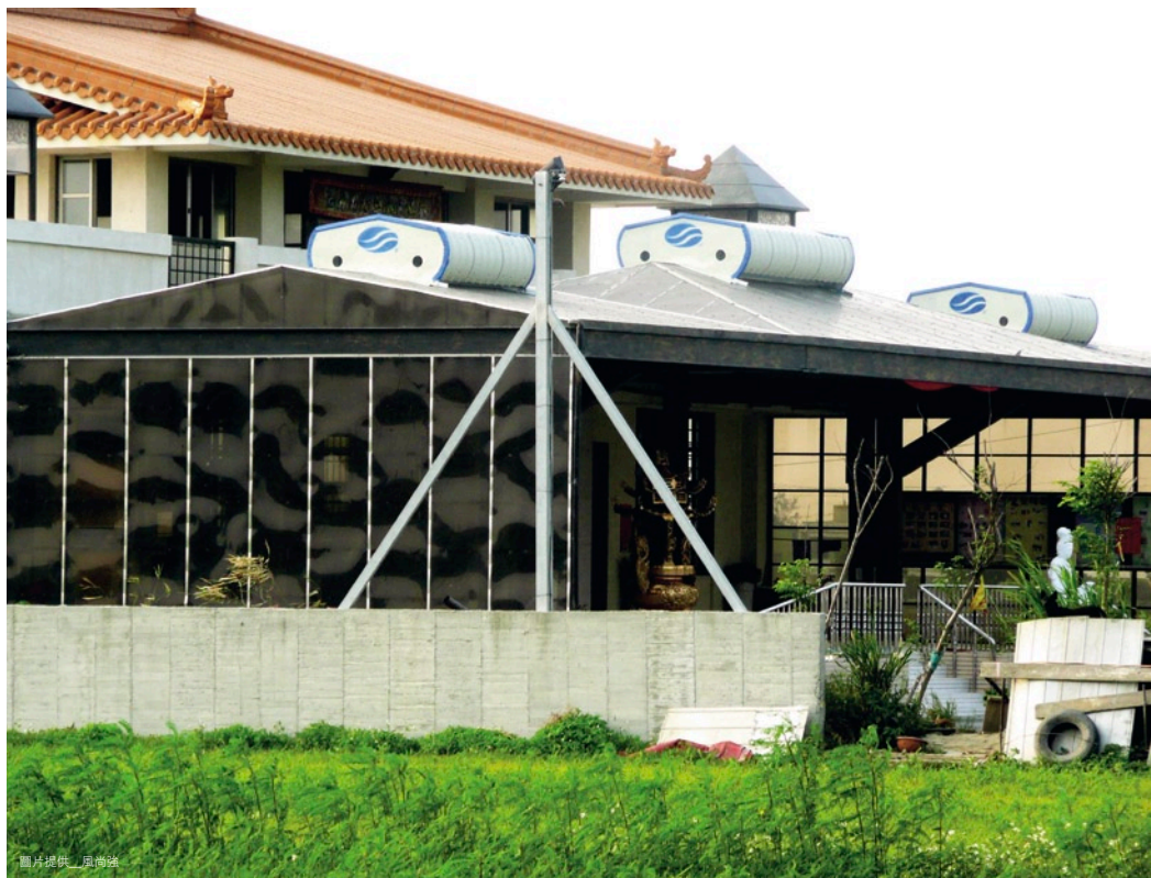
目前新型的通風塔設計，可在通風塔兩側自行形成滾動的氣流加速槽，強迫室內熱空氣排出。
