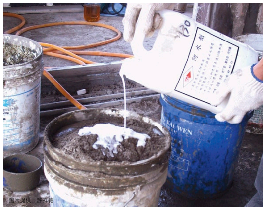
填縫防水工法
