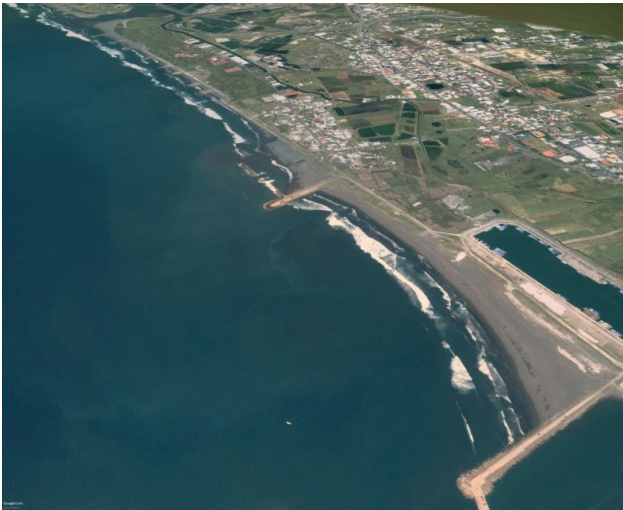
烏石漁港南側離岸堤及突堤群 2002 年衛星影像
