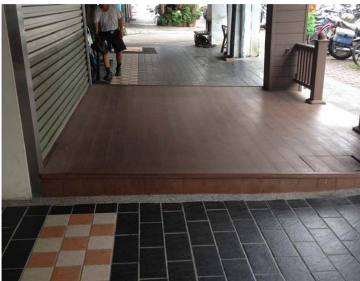
(2)坡道處理：坡道處理不符合無障礙設計規範坡道之坡度比。
