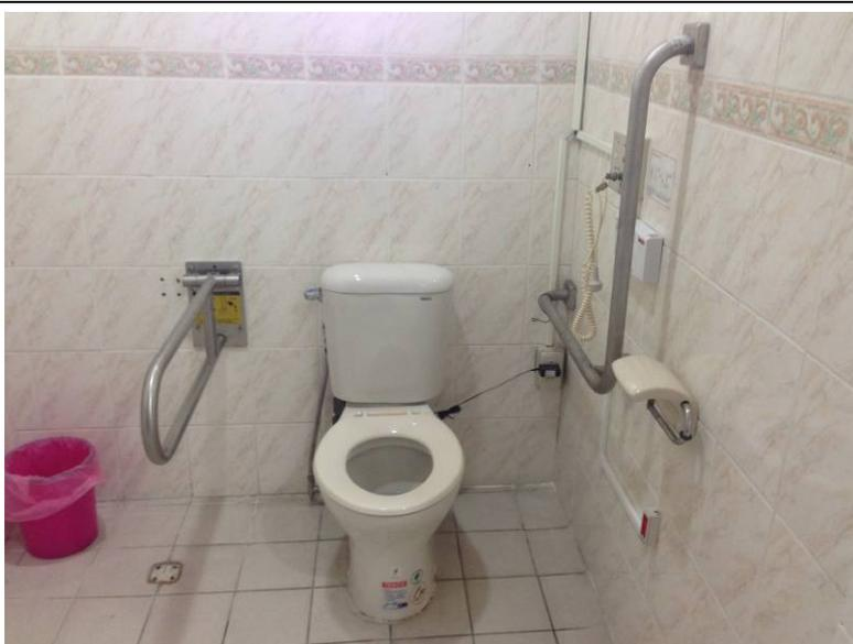
(4) 浴室/淋浴間-移位式淋浴間-扶手：兩側牆壁應設置水平扶手，其入口對向牆壁之水平扶手長度不得小於 45 公分，扶手上緣距地板面 75 公分；入口之牆壁近外緣處 2 側及座椅靠牆側，皆應設置垂直扶手，其長度不得小於 60 公分。
