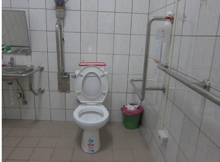
(4) 廁所盥洗室/側邊 L 型扶手：馬桶側面牆壁應裝置 L 型扶手，扶手水平與垂直長度皆不得小於 70 公分，垂直向之扶手外緣與馬桶前緣之距離為 27 公分，水平向扶手上緣與馬桶座面距離為 27 公分。
