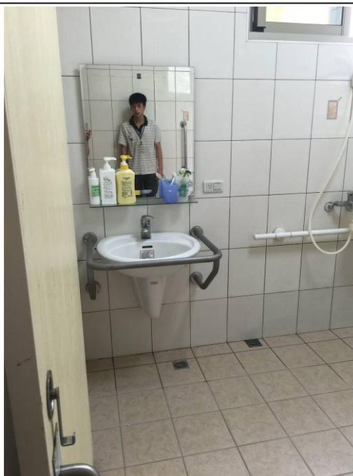
(3) 浴室/輪椅進入式淋浴間-扶手：除入口側及設置座椅側外，另兩面牆皆需設置扶手，距地板面高度 75 公分，距牆角 15 公分內得不設置扶手且入口側邊座椅處應設置高度 75 公分之可動式扶手。
