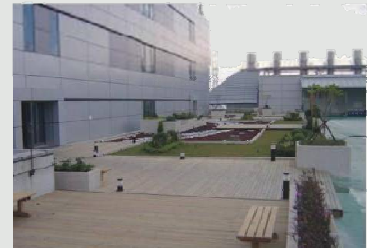
雨水蓄水生態池
