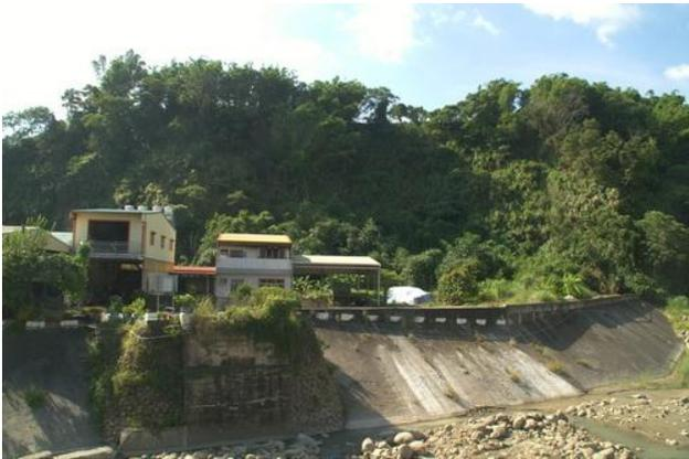
照片 9 已有崩塌現象的邊坡，應盡量維持坡趾的穩定，使邊坡得以自然植生復育。
