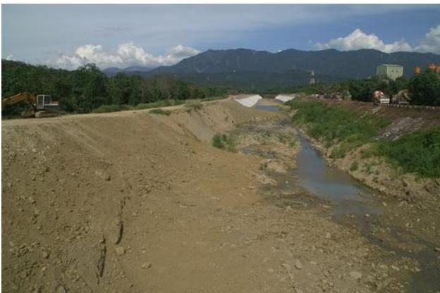
照片 11 八八水災期間的洪水造成華興溪的河岸侵蝕災害，堤防損毀嚴重。
