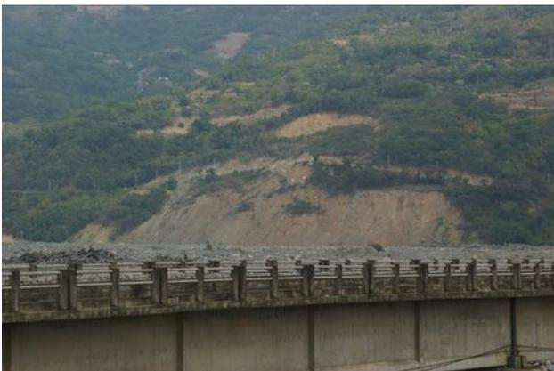
照片 5 太麻里溪潰堤的洪流造成東-42 縣道下邊坡的崩塌及道路流失。
