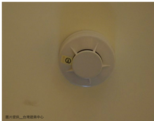
差動式火警探測器 (上圖) 定溫式火警探測器(下圖)
