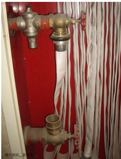
圖片提供_麥浩斯 消防栓的水帶及瞄子
