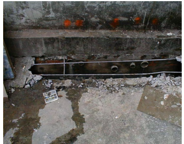
用戶接管施作前
