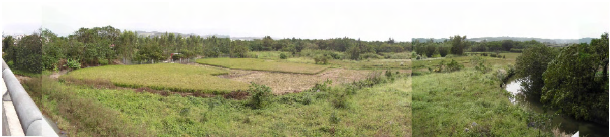
圖 1-38 水資源回收中心現況
