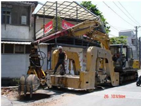
圓形鋼環擋土—搖管機
