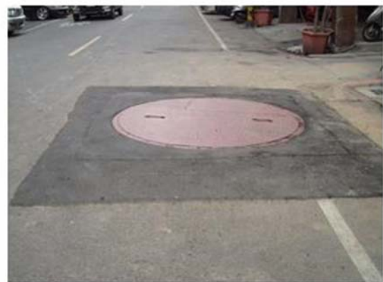
臨時覆工板及AC修復
