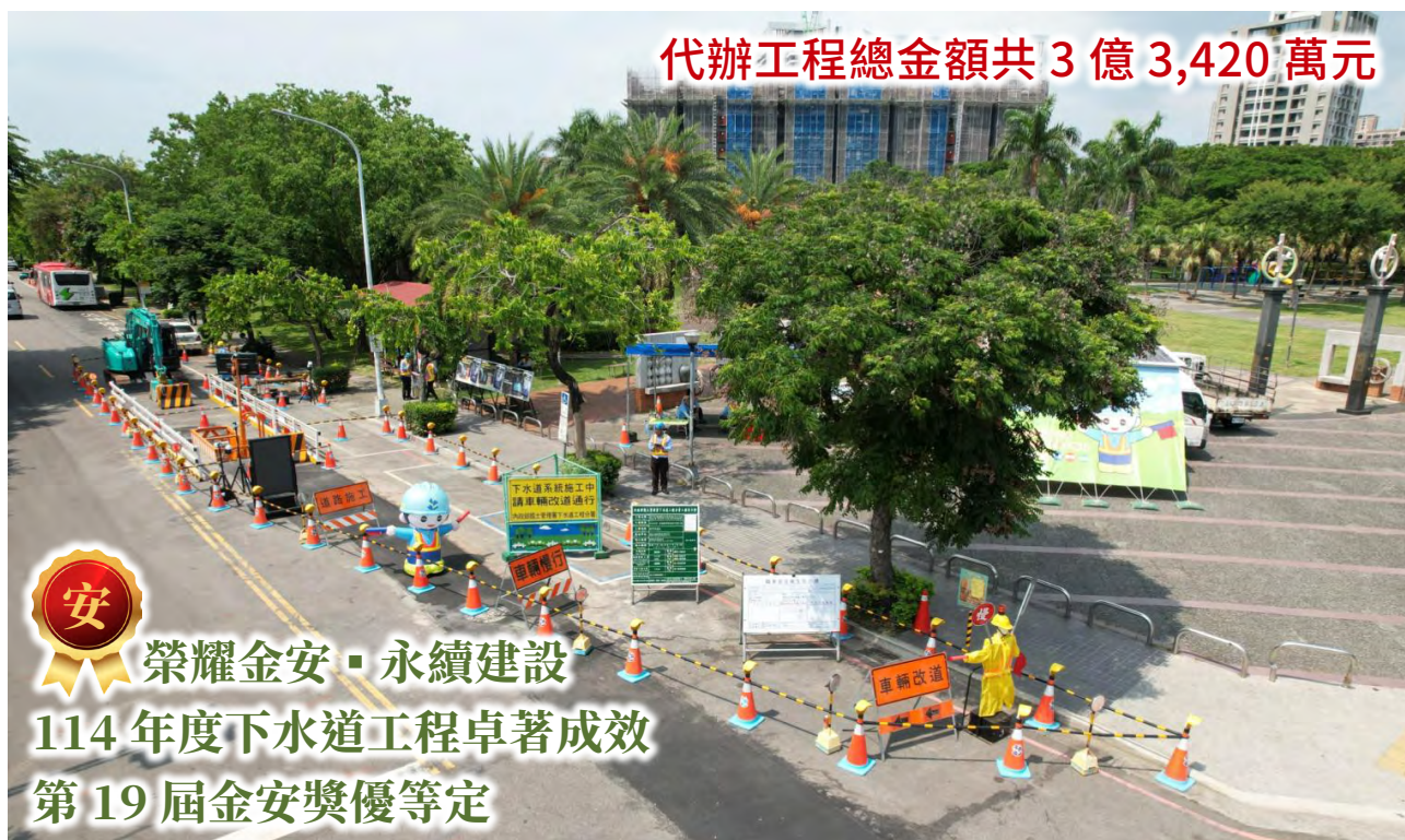
► 臺中市 11 期重劃區及四張犁地區污水下水道系統工程 - 第 2 分標（四平路及昌平路等區域）
