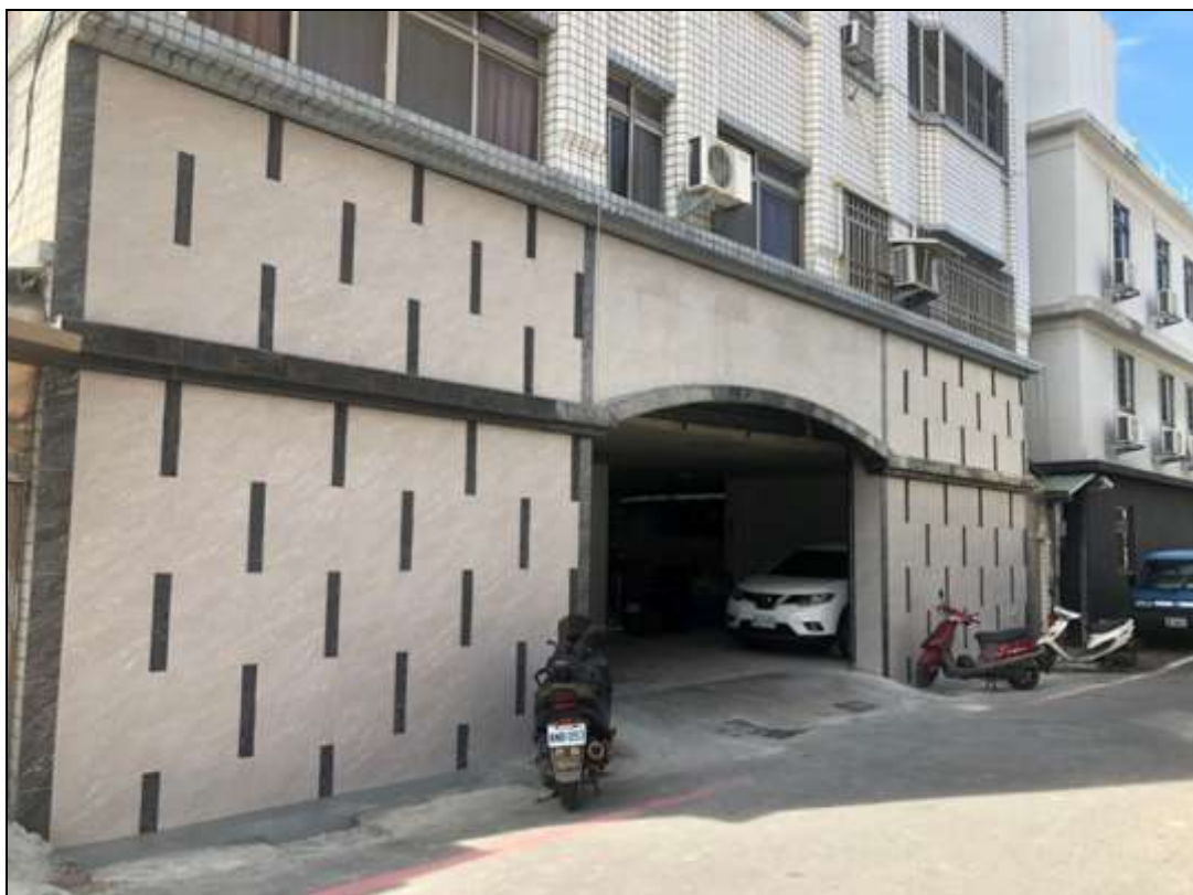
↑ 示範案例補強後一樓外牆 (原有一樓外牆變更為剪力牆並進行美化)
