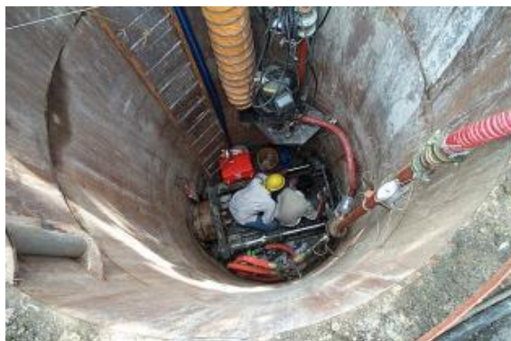
短管推進施工圖
