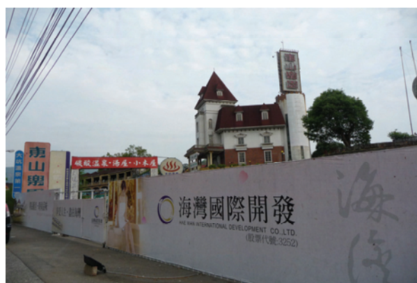
大門封閉園區內部整修
