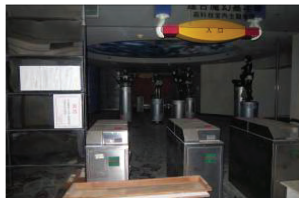
入口處(四)封閉現況
