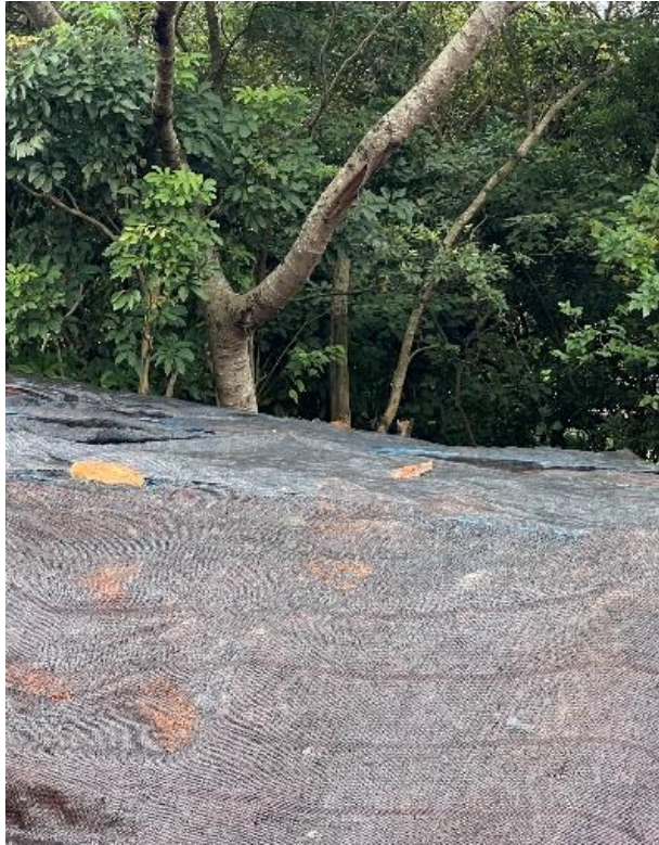
土方上方鋪設防塵網，避免揚塵走沙情形
