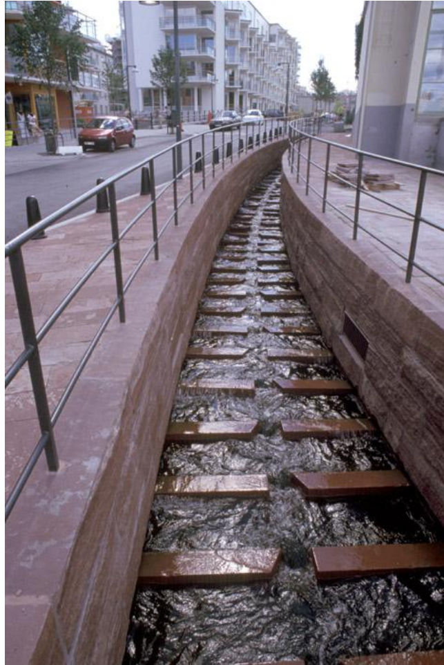
圖 10 瑞典斯德哥爾摩哈瑪碧的雨水收集淨化渠道圖
