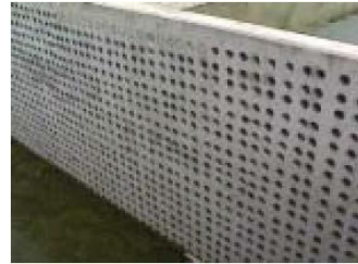
b. 混凝土整流壁照片
