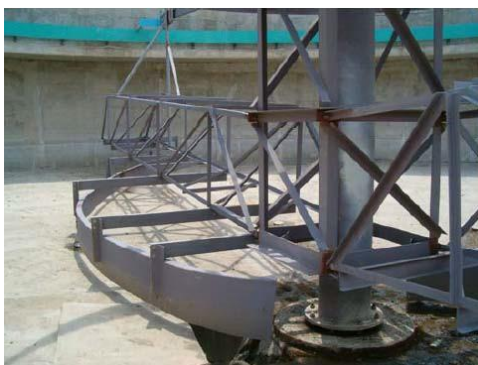
圖 4.37 螺線型刮板
