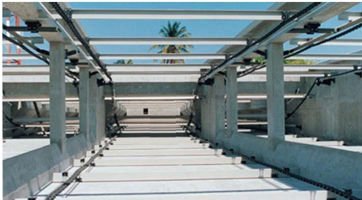
圖 4.33 長方形沉澱池池間採用開孔隔牆
