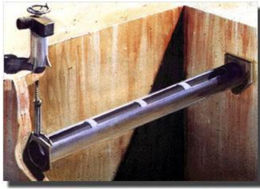
圖 4.21 長方形池刮渣管安裝示意圖
