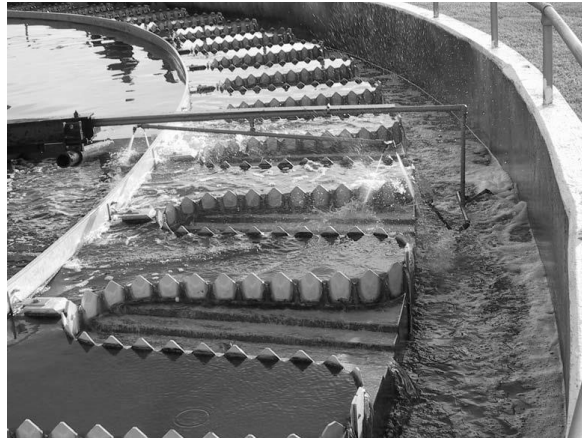
圖 4.25 噴水系統去除圓形池蛇狀溢流堰上的藻類
