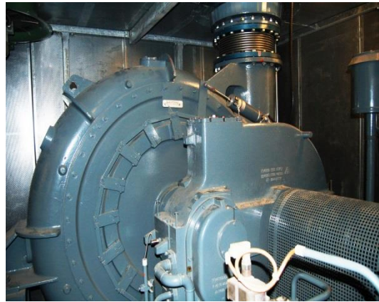
圖 5.58 單段離心式鼓風機(馬達+增速機驅動)
