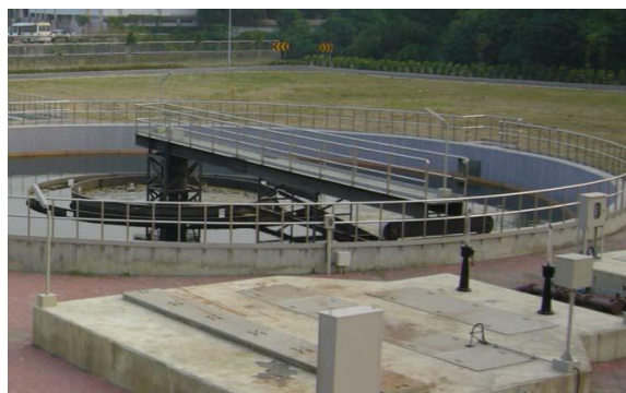
圖 4.44 周邊驅動式驅動機照片(斗六市水資源回收中心例)
