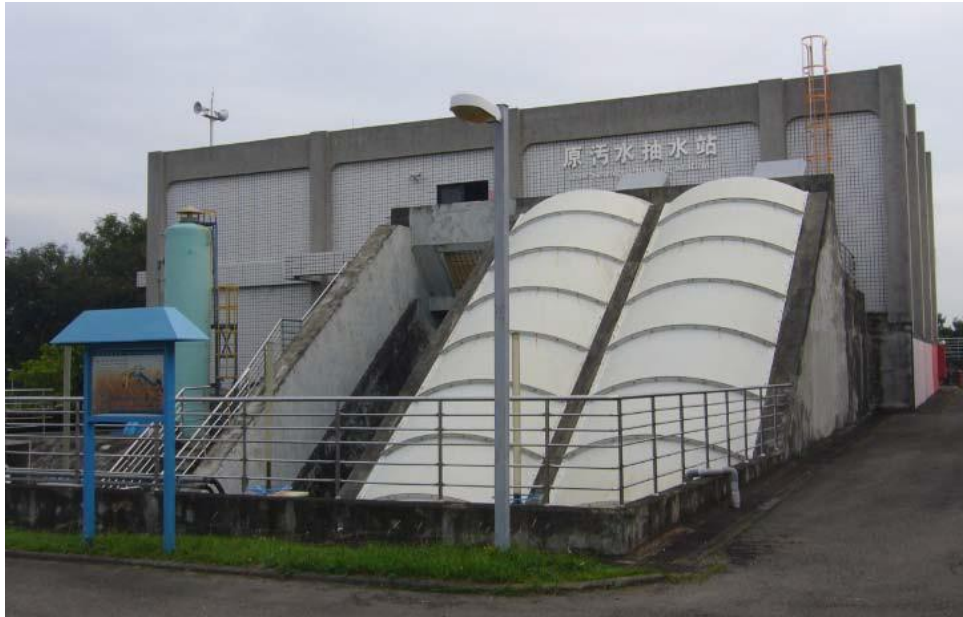
原污水抽水站照片
