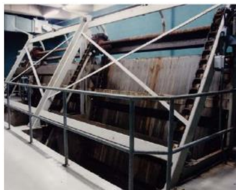
b.實際安裝照片
