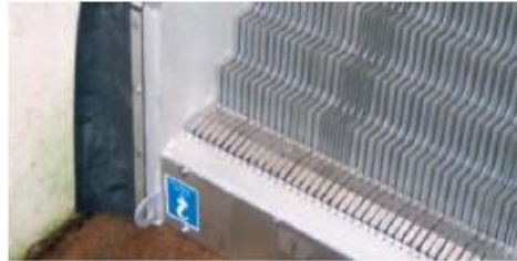
b.階梯式細攔污柵裝設照片 c.裝設在渠道內之階梯式柵板
