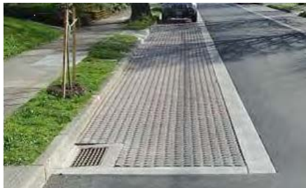
透水鋪面停車格周邊的混凝土路緣
