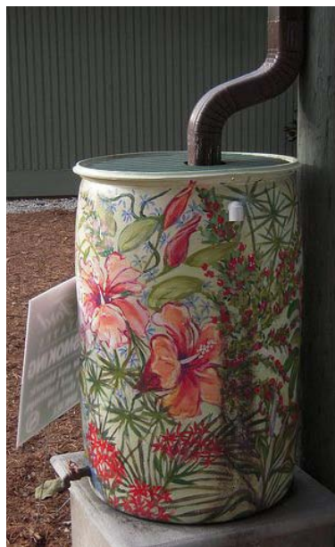
落水管出口直接連結雨水桶
