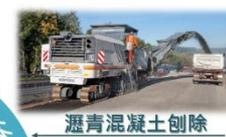
瀝青混凝土路面達使用年限，透過刨除方式將刨除料運送工廠進行加工、破碎
