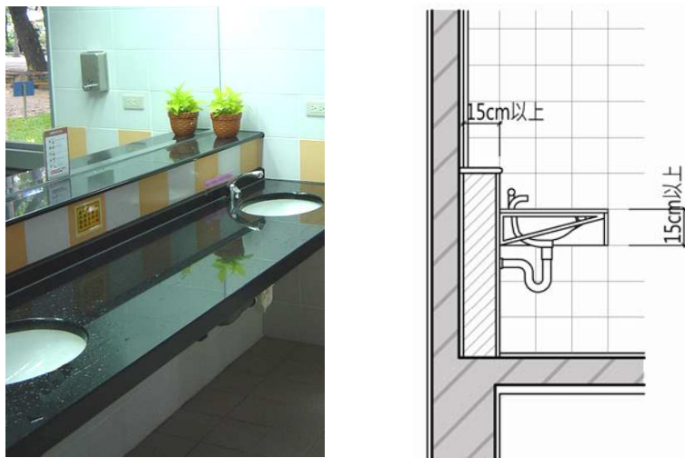
圖 3-41 廁所洗面盆設置案例
