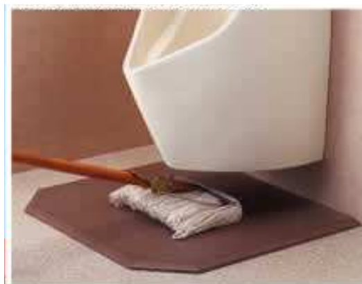
圖 3-26 小便器下方之清掃空間
