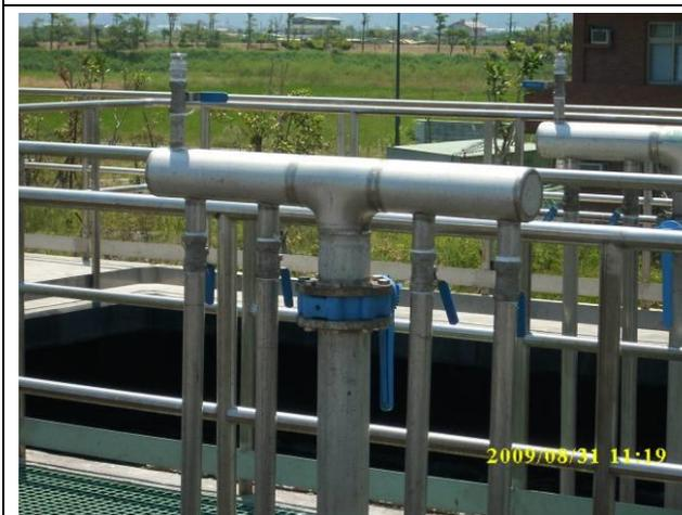
鼓風機管路依曝氣需求調整開度大小，避免開度過大造成泡沫過多，開度過小則溶氧不足。
