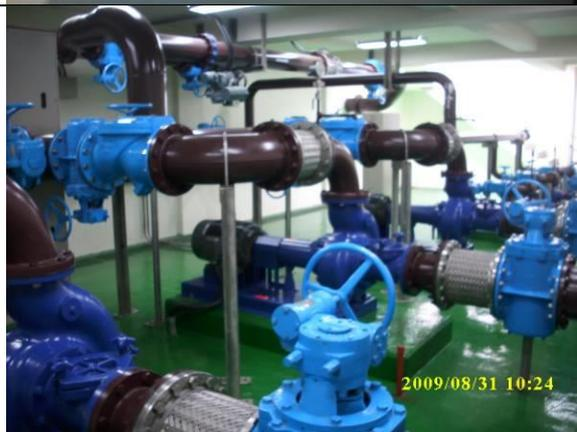
迴流污泥泵主要依據控制模組設定時間操作，以利微生物養成。
