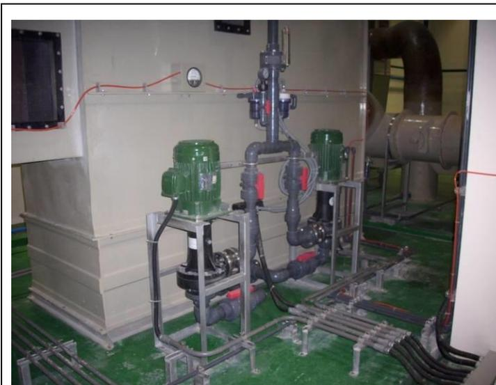
循環泵主要功能為抽取水槽內水體，並輸送水體至灑水器噴灑淋洗，用以吸收氣體污染物。
