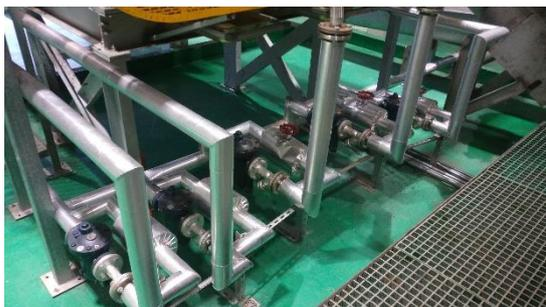
b. 於開啟鍋爐確認正常後，於蒸氣管路最低點開閥洩水，致蒸氣出現關閉
