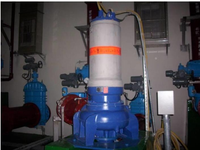
1. 進流泵受超音波液位計感應高度訊號後啟動
