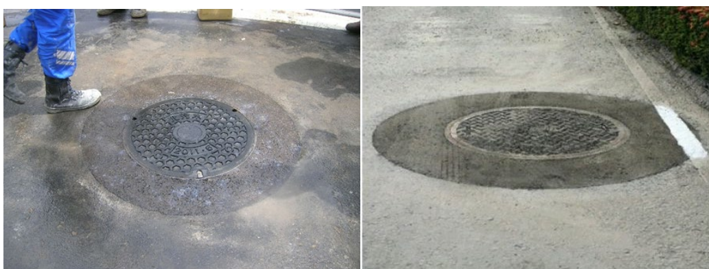
圖 5.14 圓形切割工法施工成果
