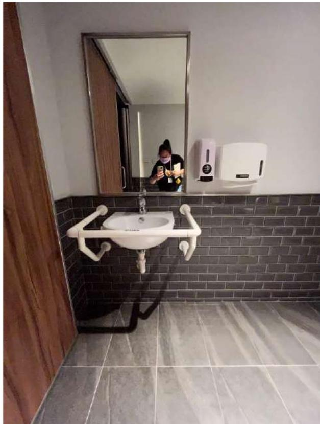
(3) 廁所盥洗室/廁所盥洗室設計/求助鈴/位置：無障礙廁所盥洗室內應設置 2 處求助鈴，1 處按鍵中心點在距離馬桶前緣往後 15 公分、馬桶座墊上 60 公分，另設置 1 處可供跌倒後使用之求助鈴，按鍵中心距地板面高 15 公分至 25 公分範圍內，且應明確標示，易於操控。
