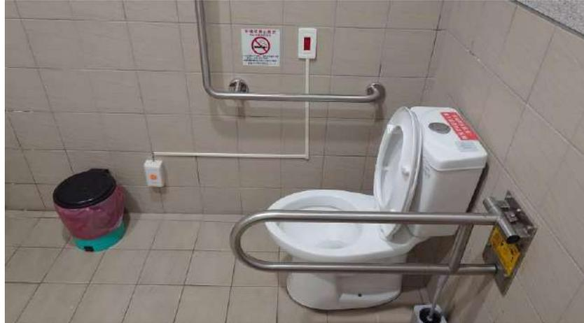
(3) 廁所盥洗室/側邊 L 型扶手：馬桶側面牆壁裝置扶手時，應設置 L 型扶手，扶手外緣與馬桶中心線之距離為 35 公分，扶手水平與垂直長度皆不得小於 70 公分，垂直扶手外緣與馬桶前緣之距離為 27 公分，水平扶手上緣與馬桶座墊距離為 27 公分。L 型扶手中間固定點並不得設於扶手垂直部分。廁所盥洗室/可動扶手：馬桶至少有一側為可固定之掀起式扶手。使用狀態時，扶手外緣
