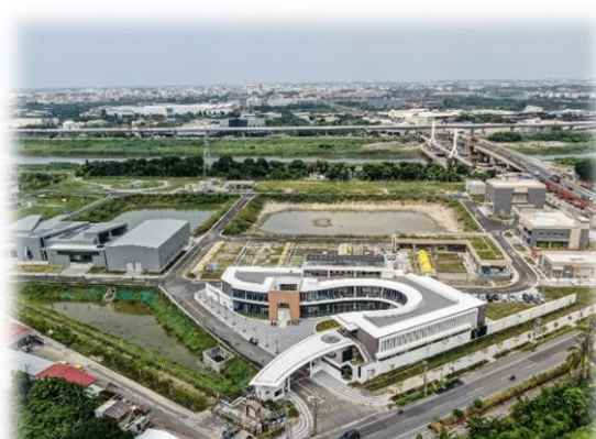
永康水資源回收中心及再生水廠
