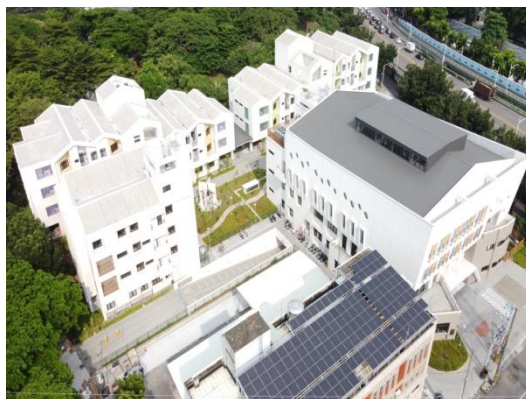
第 21 屆公共工程金質獎 優等-衛生福利部南區兒童之家院舍遷建工程
