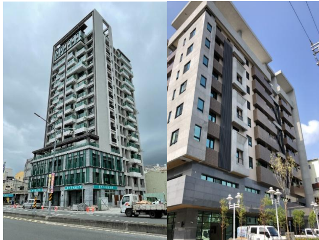
▲協助臺南市 0206 美濃地震受災社區完成重 (左圖為維冠金龍大樓；右圖為大智市場)
