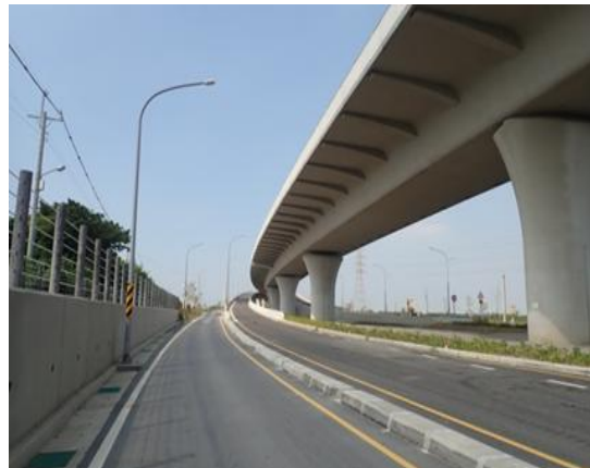
生活圈道路系統建設計畫 - 臺南都會北外環道路第 3 期新建工程
