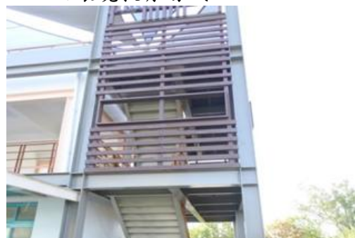
安順鹽場建物整修工程
