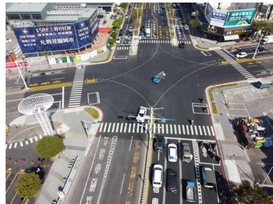
海安路(和緯路~中華北路)及公園南路(西門路~海安路)道路優質化工程(第一標-海安路)
