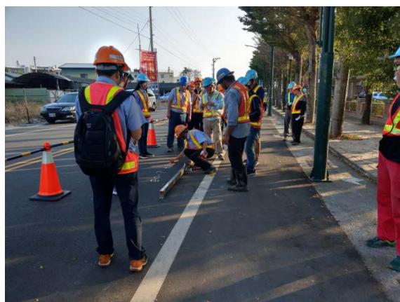
國營事業管線挖掘市區道路施工回填復舊 ——彰化縣考評
