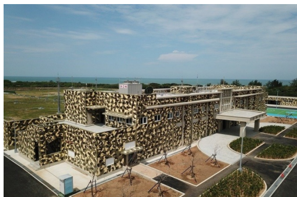
港平營區遷建案之三芝新建營舍工程
