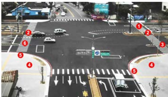
提升道路品質計畫－臺中市清水區五權南路 人行步道改善建置工程
