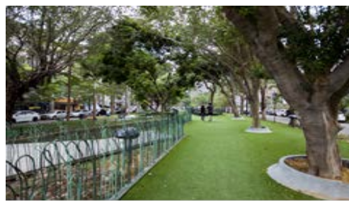
新竹市隆恩圳沿岸綠帶工程
