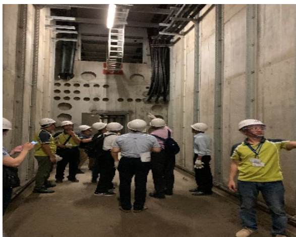
共同管道現勘
