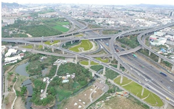
高雄市高速公路交流道匝道周邊綠帶低地化微滯洪工程(鼎金系統交流道)
