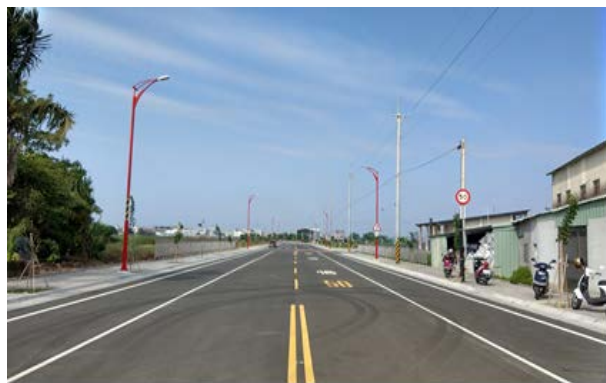
生活圈道路系統建設計畫 新港都市計畫4號道路新闢工程
