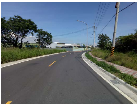
生活圈道路系統建設計畫 岡山區致遠路第一期拓寬工程
