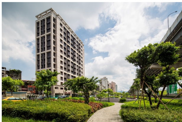
新北市三重區大安段社會住宅(1館)
