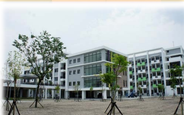
內政部消防署訓練中心新建工程
