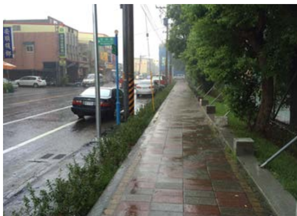
市區道路人本環境改善計畫-高雄市前鎮區林森路(中華路-成功路)人行環境及景觀改善工程(106年度)
