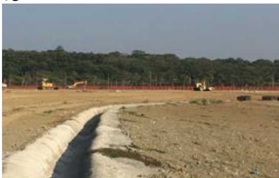
綜合示範社區既埋垃圾清除及整地第二期工程
