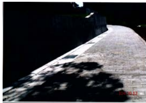
淡海新市鎮公司田段184地號增設4M道路工程
