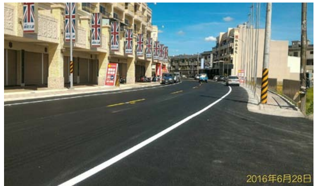
高雄市仁武八德西路拓寬工程
