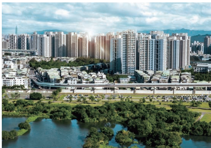
板橋浮洲合宜住宅
