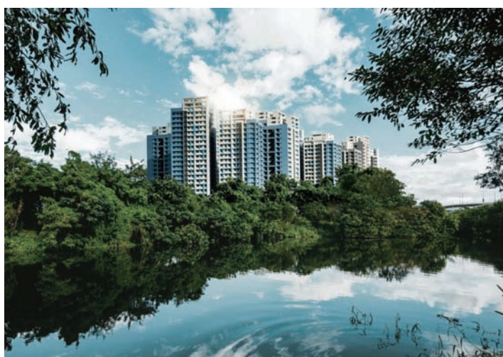
板橋浮洲合宜住宅
