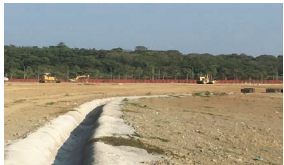
綜合示範社區既埋垃圾清除及整地第二期工程
